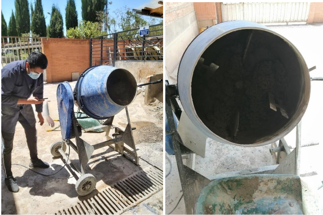
Ilustración 7: Elaboración de mezclas de hormigón (fuente propia).
