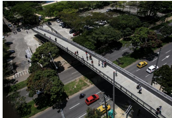
Figura 10. Puente Peatonal EAFIT, Universidad EAFIT, Medellín, Colombia, Fuente: Coninsa (2017).
