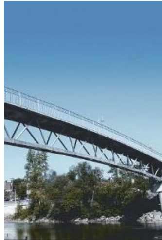
Figura 3. Sherbrooke footbridge, Canadá, Fuente: RdConcrete (2020).
