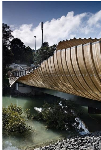
Figura 7. Papatoetoe footbridge, Nueva Zelanda, Fuente: Archilovers (2014).
