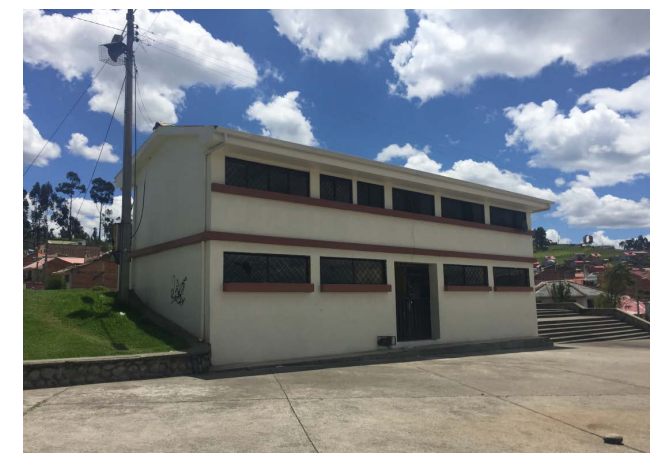
IMG-1.20 Construcción existente (oficinas, bodega y SS.HH)
