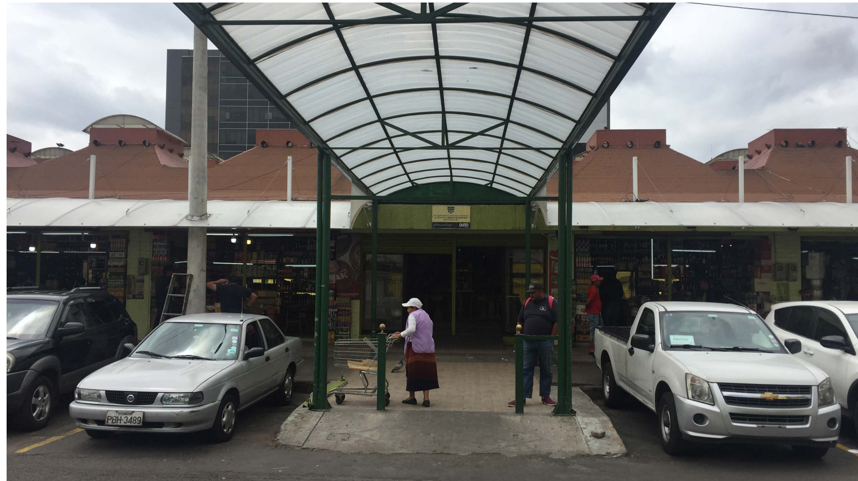
IMG-2.16 Ingreso principal peatonal al mercado Iñaquito
