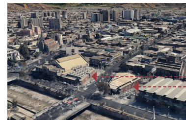
IMG-2.36 Vista aérea pergolas San Francisco y Santa María
