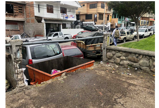
IMG-1.26 Zona de depósito de basura
