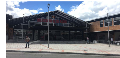
IMG-2.49 Ingreso principal mercado 12 de abril
