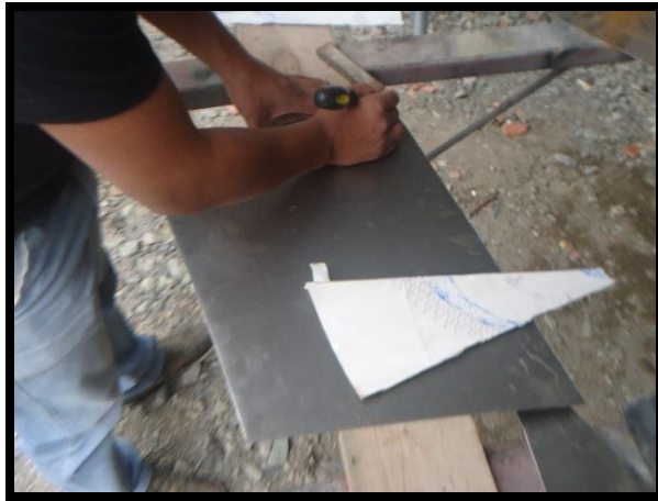
Cortado de planchas de metal. (81) foto autor
