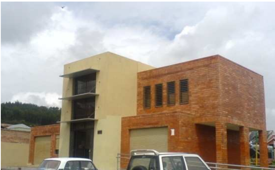
Foto N°1: Local donde funciona El Subcentro de Salud “Tomebamba”
