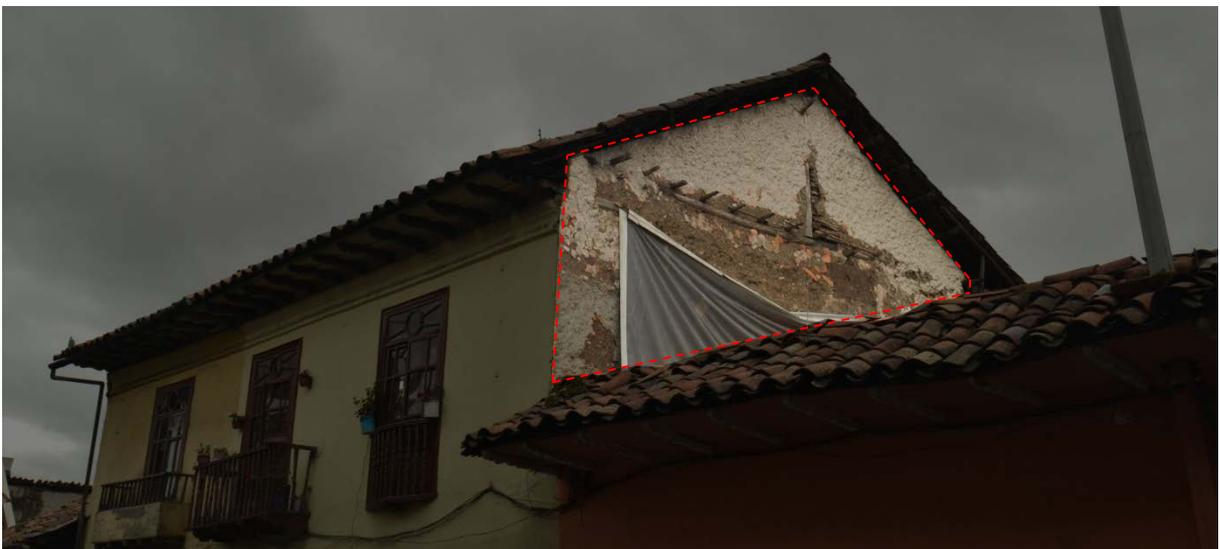
Figura 8. Edificación de bahareque que utiliza mortero de cemento para cubrir deterioros
