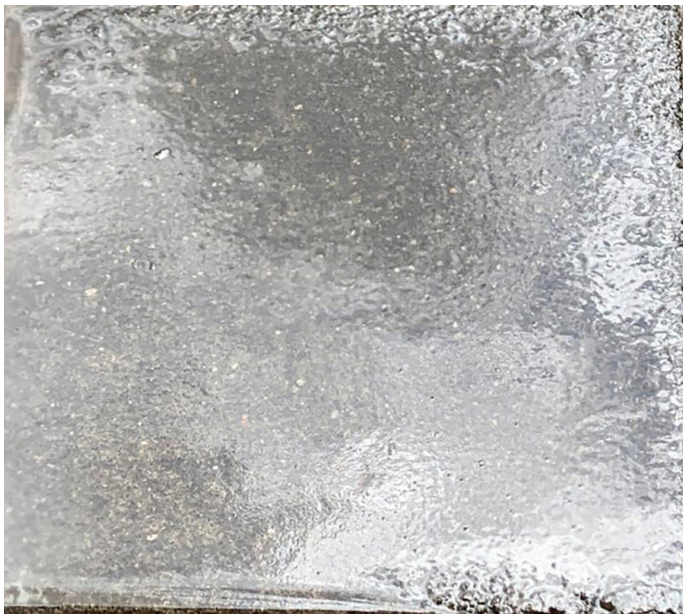
Figura 33. Epóxico aplicado en hormigón
