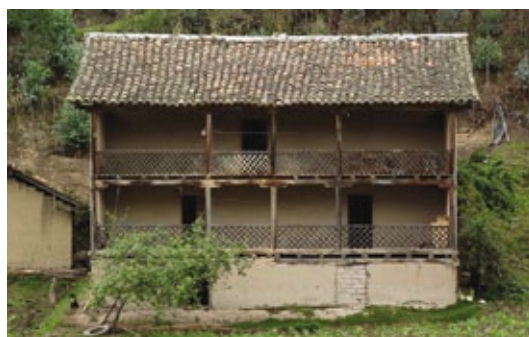
Figura 6 Tipología 1. Parroquia de Quingeo. Estructura de madera y cerramientos de tierra.
