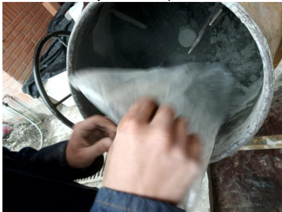
Ilustración 20. Agregar Cemento lentamente.
