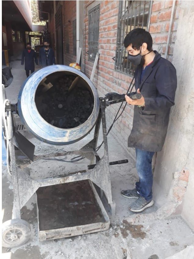
Ilustración 93. Mezcla del hormigón con 0.35% de fibra de vidrio del peso.
