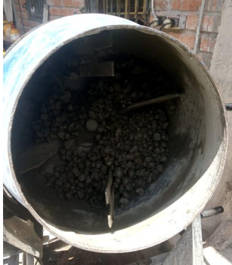
Ilustración 19. Agregar 1/3 de agua a la mezcla.
