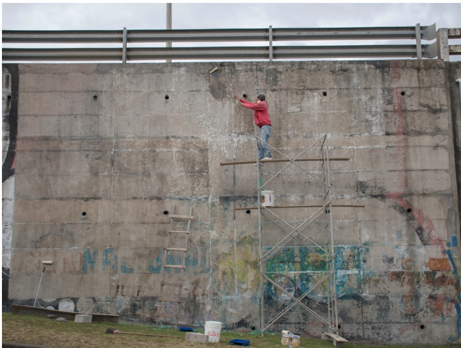
Imagen N° 153. Fotografía: Paúl León, segundo proceso de preparación del muro (2019)
