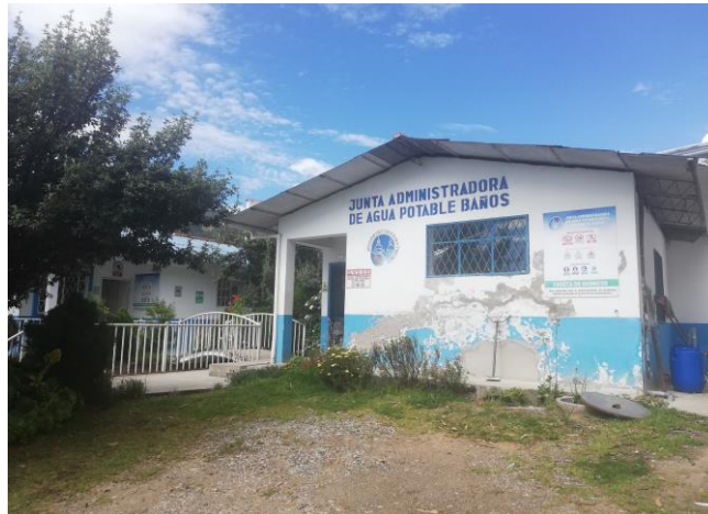
Ilustración 13: Caseta de Químicos-Planta de Tratamiento de Agua Potable de Cochapamba Fuente: Elaboración Propia
