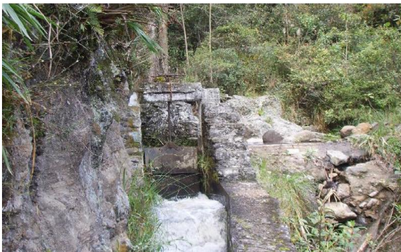
Ilustración 11: Etapa de Captación-Planta de Tratamiento de Agua Potable de Cochapamba
