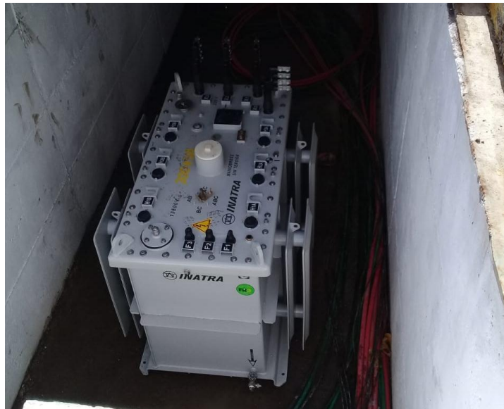
Figura 4. 18. Transformador trifásico sumergible EEASA.
