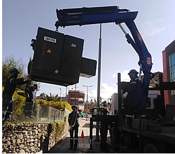
Figura 4. 3. Montaje del transformador.
