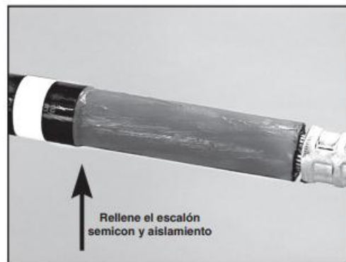
Figura 3. 42. Compuesto en el escalón semi conductor y aislamiento [35]
