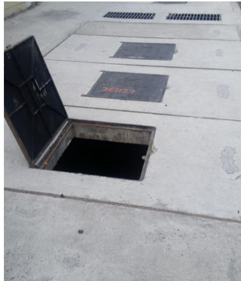
Figura 2.16 Losa superior de cámara terminada.
