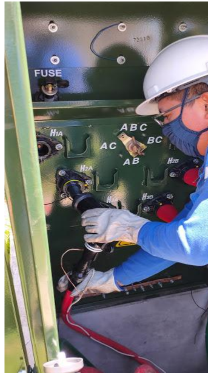
Figura 4. 5. Inserción de conectores tipo codo EEASA.
