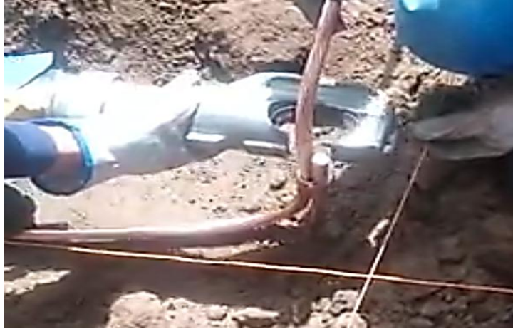
Figura 4. 62. Unión de varilla Copperweld con cable 250 MCM mediante conector tipo C utilizando machinadora EEASA.
