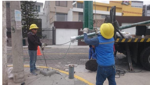
Figura 5. 5. Montaje del poste en la base. EEASA
