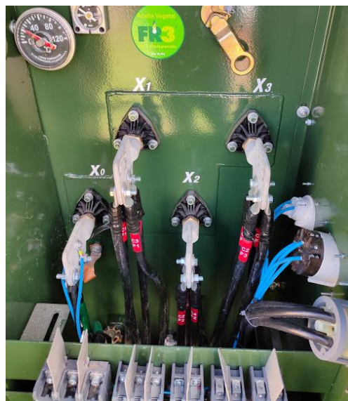
Figura 4. 11. Conexión de los cables del neutro de cada uno de los circuitos. EEASA
