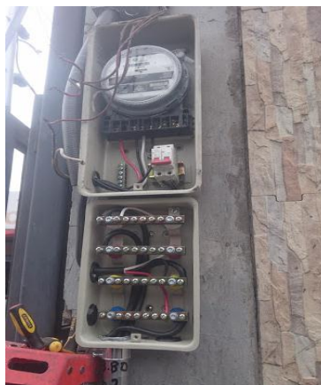
Figura 3. 98. Conexión de los medidores a la caja de distribución EEASA.
