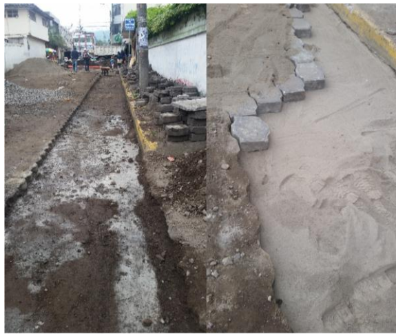
Figura 2.10 Reposición en calzada con adoquín Píllaro EEASA
