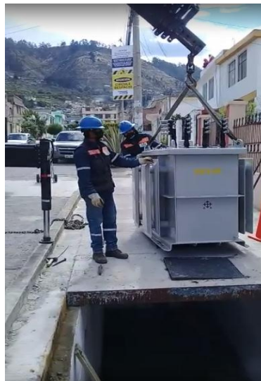
Figura 4. 22. Montaje del transformador sumergible EEASA.
