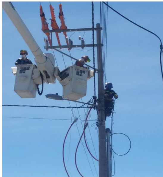
Figura 4. 41. Montaje de seccionador fusible. EEASA
