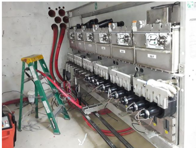
Figura 4. 34. Armado de los conectores tipo codo
