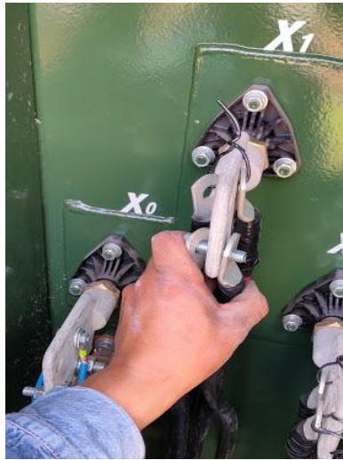
Figura 4. 10. Conexión de los terminales de compresión a las paletas. EEASA
