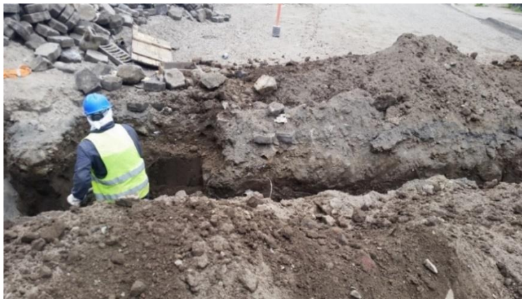
Figura 2.1 Excavación para canalización en Píllaro.
