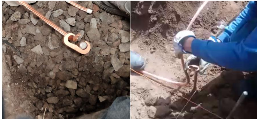
Figura 4. 60. Unión de varillas con el conductor mediante conectores tipo C. EEASA
