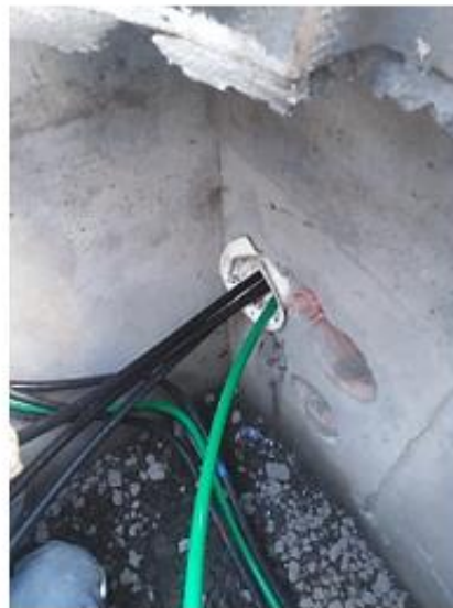
Figura 3. 11. Protección al ingreso del ducto. EEASA
