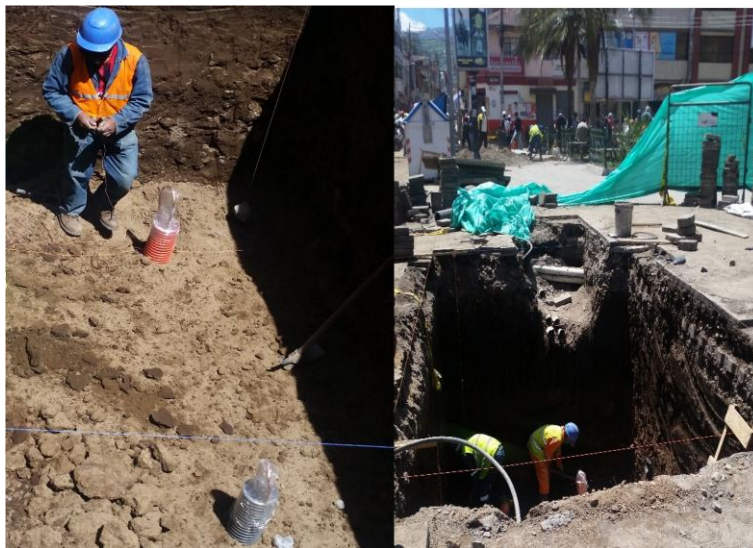
Figura 4. 65. Relleno con tierra todo el sistema. EEASA.
