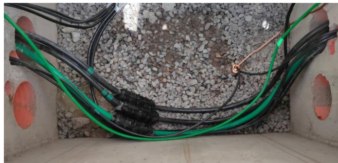
Figura 3. 86. Empalme de bajo voltaje finalizado EEASA.
