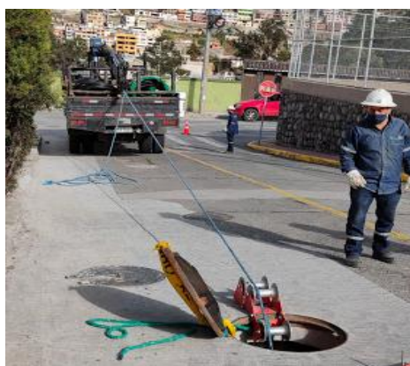
Figura 3. 14. Jalado de cables EEASA.
