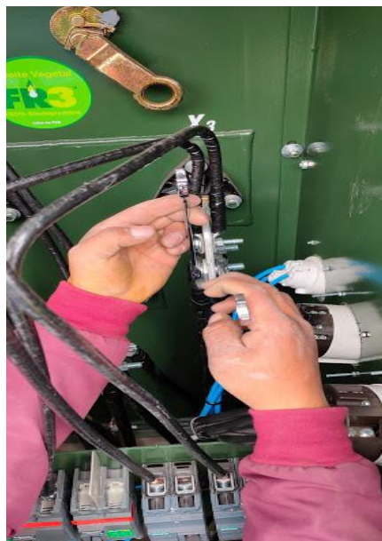
Figura 4. 13. Conexión de los circuitos de alumbrado público. EEASA
