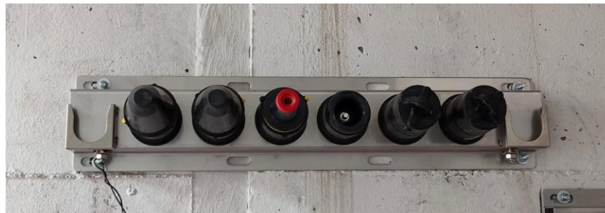
Figura 3. 55. Barra premoldeada 6 posiciones de 200 A y 600 A EEASA.
