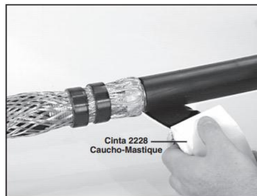
Figura 3. 47. Cinta scotch 2228 de caucho mastique sobre el cable [35].
