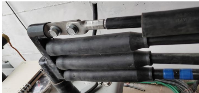
Figura 4. 28. Conexión de los terminales tipo ojo en el Bushing del transformador EEASA.
