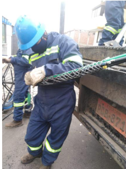
Figura 3. 10. Colocación de la malla de acero a los conductores. EEASA
