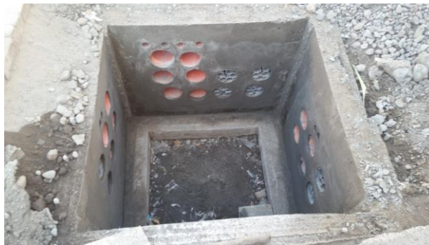
Figura 2.12 Orificios laterales terminados EEASA.
