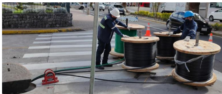
Figura 3. 6. Carretes en el pozo de envío EEASA.
