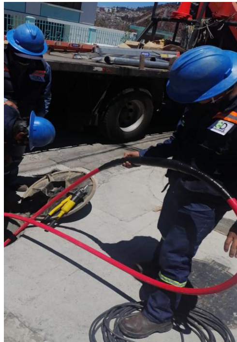
Figura 3. 51. Empalme finalizado EEASA.
