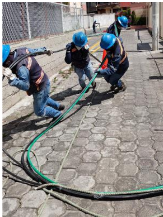
Figura 3. 13. Jalado de cables. EEASA
