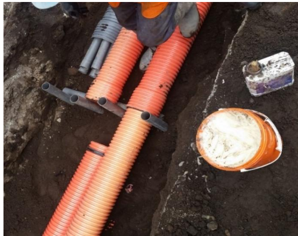
Figura 2.5. Unión de tuberías de 160 mm mediante embone
