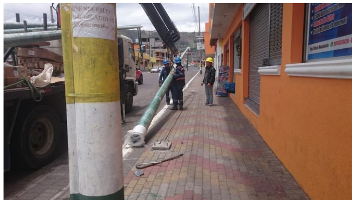
Figura 5. 4. Retiro del plástico protector del poste. EEASA
