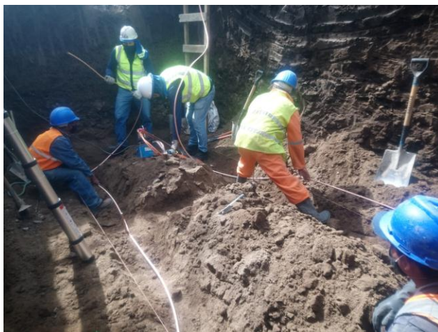
Figura 4. 57. Tendido del conductor 250 MCM. EEASA
