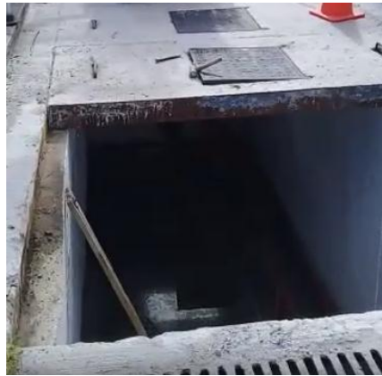
Figura 4. 21. Retiro de las tapas de la cámara de transformación EEASA.
