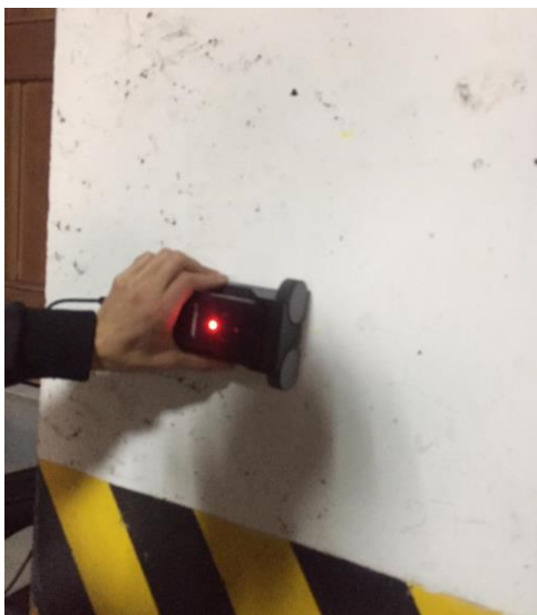
Figura 36. Detección de ubicación de acero transversal.
