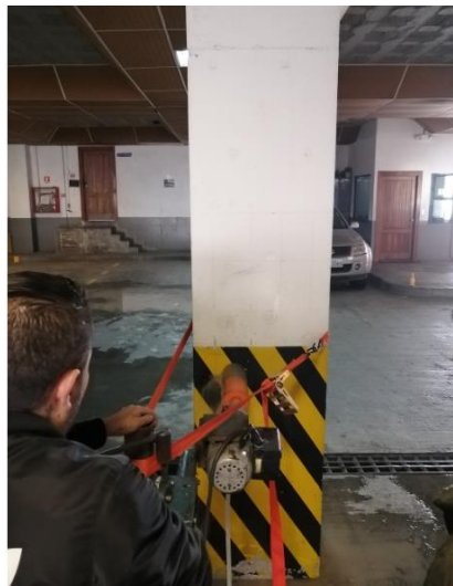
Figura 46. Equipo colocado en posición para la extracción.
