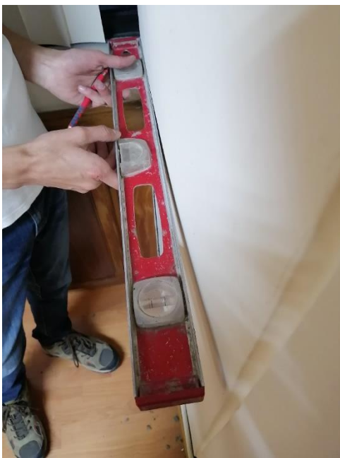
Figura 8. Hinchazón de columnas
