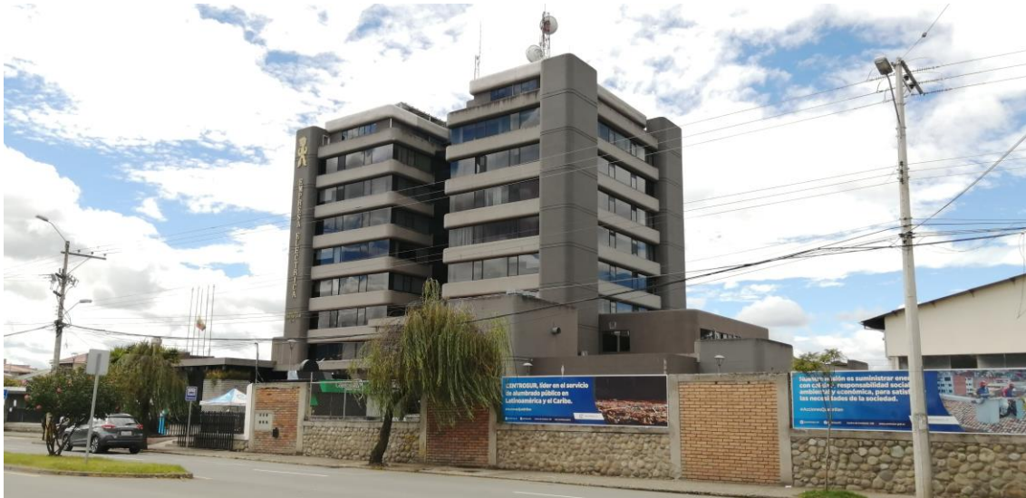
Figura 4. Fachada del edificio EERCs.
