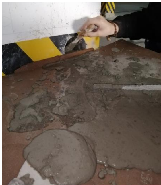
Figura 50. Sellado de orificio de extracción.
