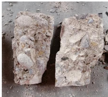
Figura 106. Falla por adherencia probeta de hormigón No: 8.
