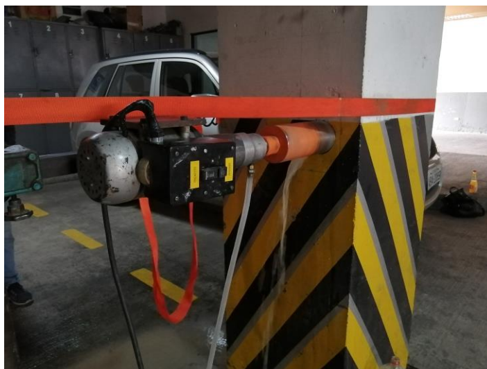
Figura 48. Abastecimiento de agua directo con una conexión manguera-equipo.
