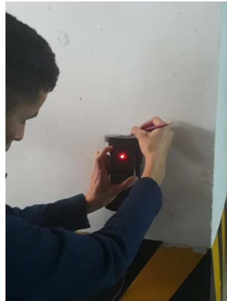
Figura 33. Detección de ubicación de acero longitudinal.
