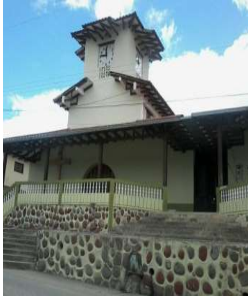
Fotografía 37. Iglesia de Casallay.
