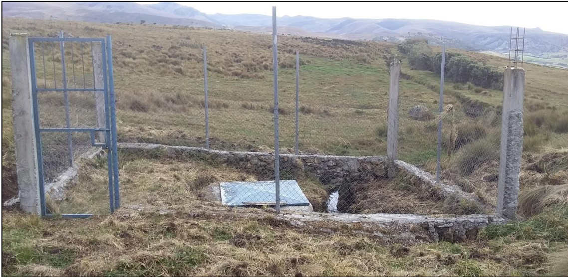
Fotografía 1. Captación Tragneran Yaku, altitud: 3.744 m.s.n.m.
