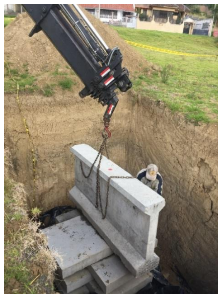
Figura 26. Ensayo de consolidación en campo.
