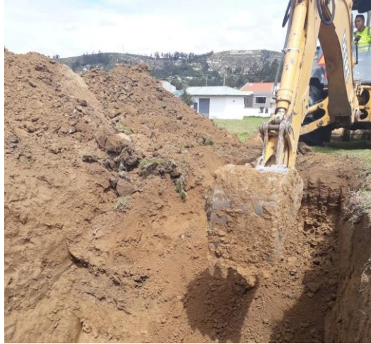
Figura 13. Calicata de extracción de muestras.
