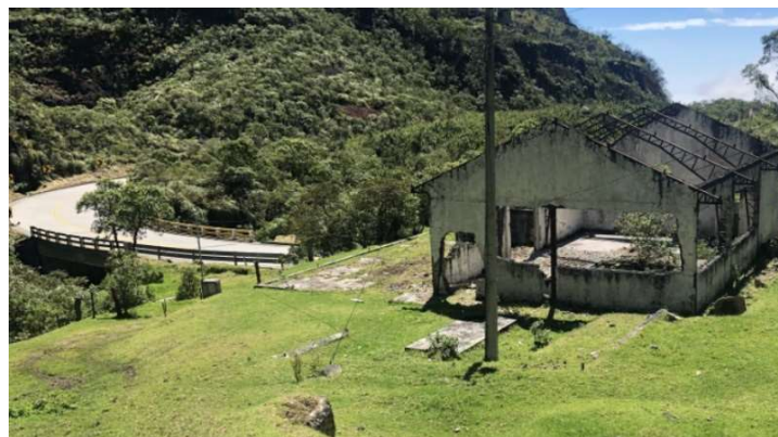
FIGURA 2.11. Estado Actual de la mini central hidroeléctrica "Molleturo" (Elaboración propia).
