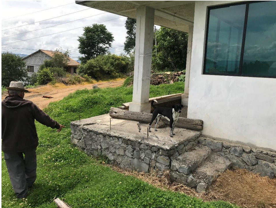
Imagen 14 Sector 4 Vía Lazareto
