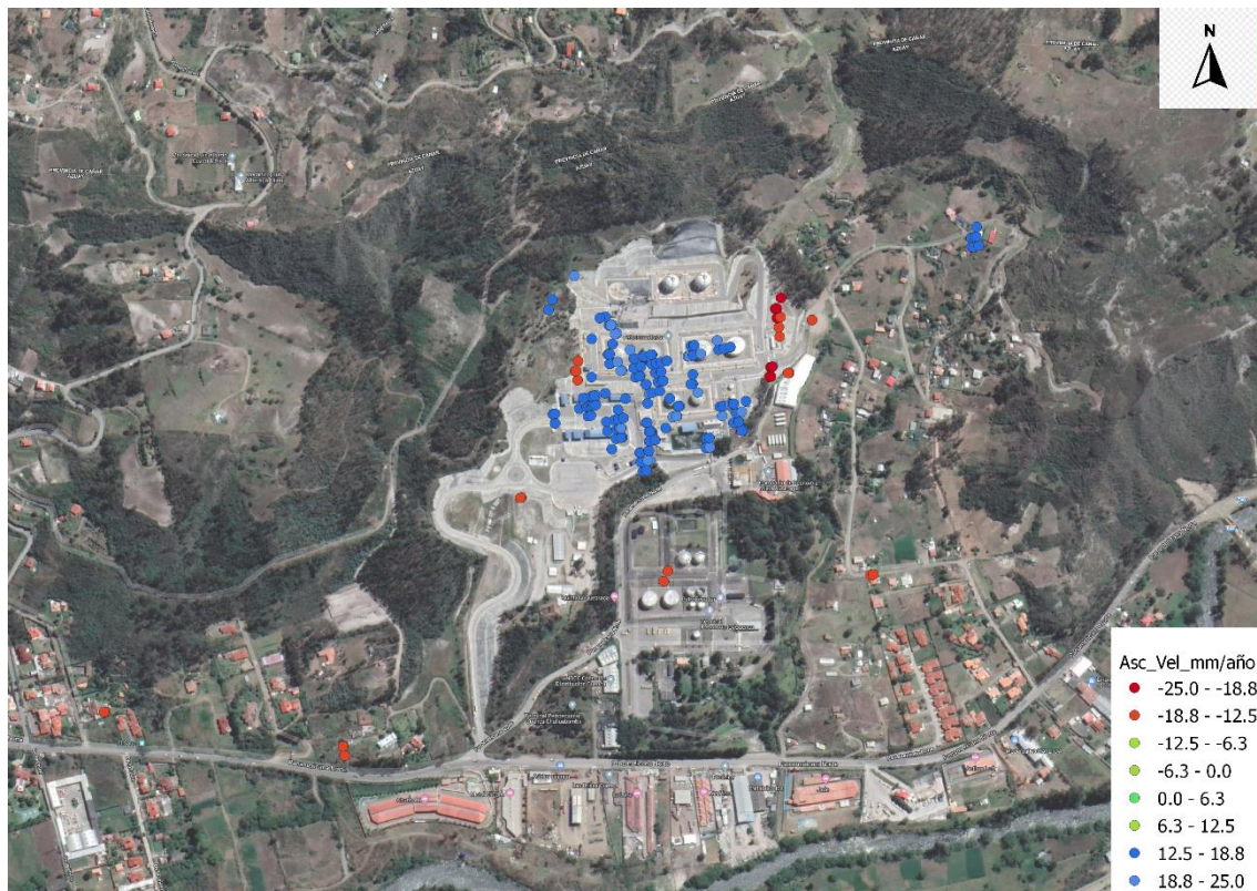
Figura 46 PS sector Esferas de almacenamiento de Gas ascendente
