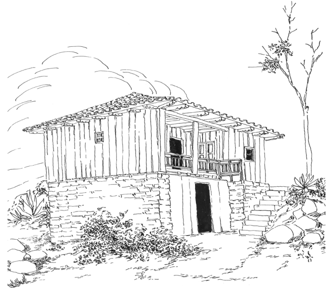
Imagen 28. Edificación en dos plantas con muros mixtos.
