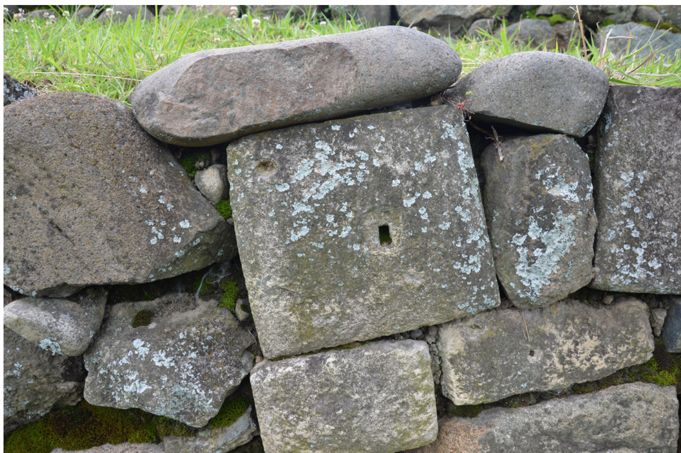
Figura 2. Característico sillar inca en una muralla del Parque Arqueológico de Pumapungo (fuente propia).
