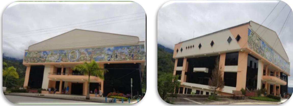
Gráfico N° 1 Edificio del GAD Municipal de San Juan Bosco
