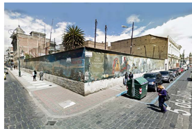
Fotografía 4.05. Estado actual vial Calle Magdalena Dávalos.
