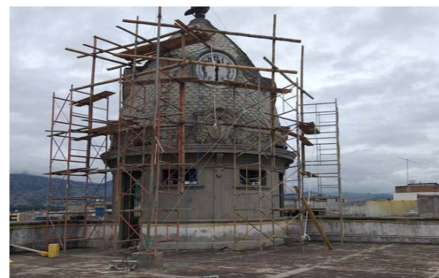
Fotografía 3.21: Restauración de la Fachada Edificio del Correo.
