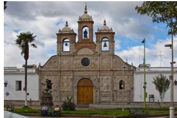
Fotografía 3.5: Catedral de Riobamba.
