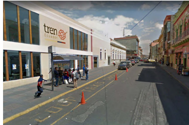
Fotografía 4.06. Estado actual vía.
