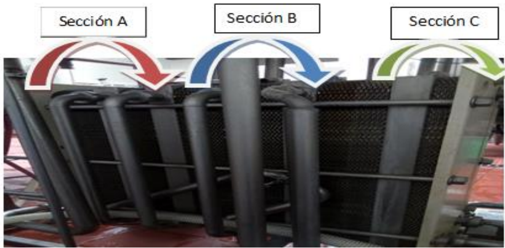
Ilustración 4. Secciones del intercambiador de calor
