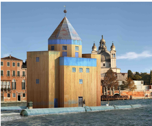
Figura 11: Teatro del Mondo, construido para la Bienal de Venecia por el arquitecto Aldo Rossi, como una manera de recuperar la memoria colectiva Fuente: Wikiarquitectura.
