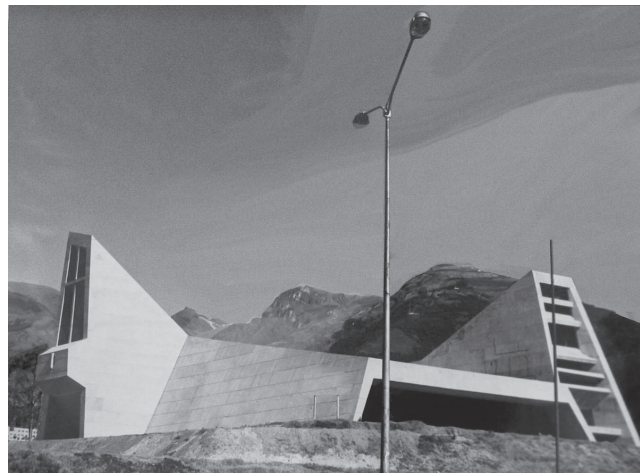
Figura 53: Templo de la Dolorosa de Milton Barragán. Fuente: Plataforma Arquitectura.
