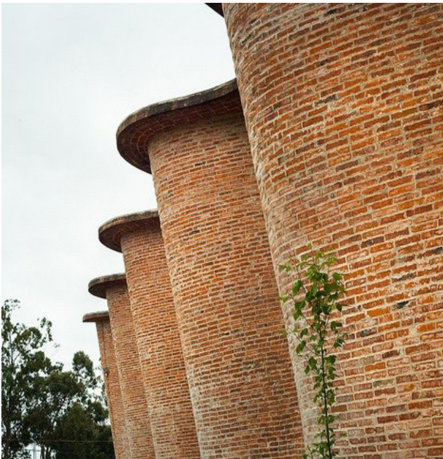
Figura 67: Iglesia del Cristo Obrero, Eladio Dieste. Fuente: Plataforma Arquitectura.
