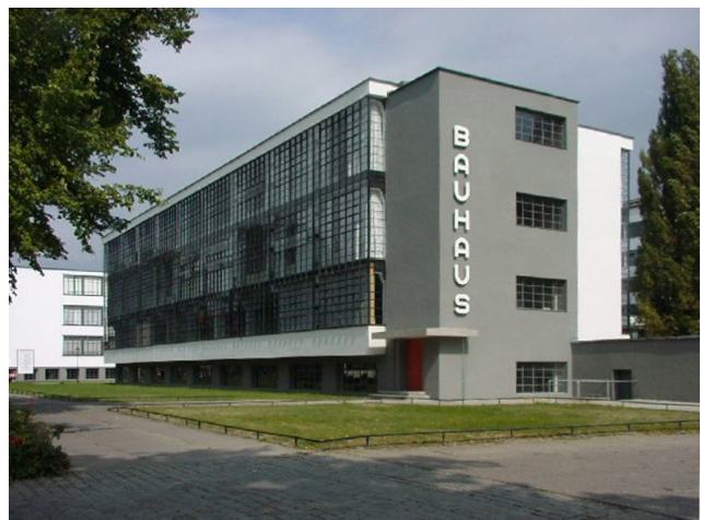
Figura 08: Edificio Bauhaus construido en Dessau, Alemania. Fuente: Wikimedia.
