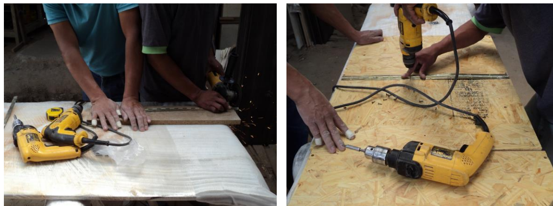
Fotografía 77 y 78: Construcción del prototipo.
