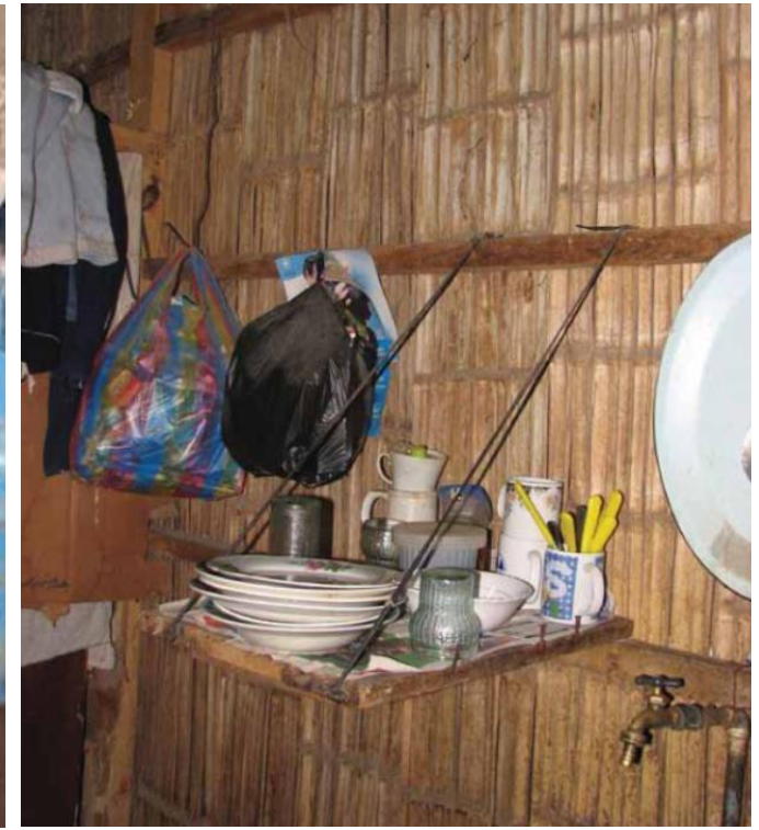
Fotografía 14: Estante plegable hecho por dueños de casa, Fuente: La vivienda económica
