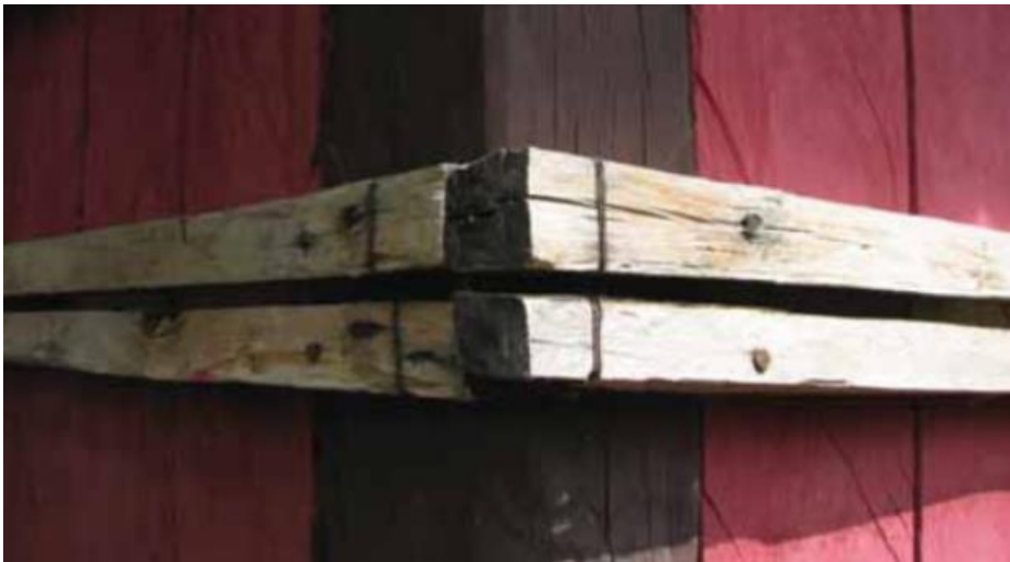
Fotografía 11: Detalle constructivo de tiras que sujetan las tablas verticales que conforman la pared, Fuente: La vivienda económica
