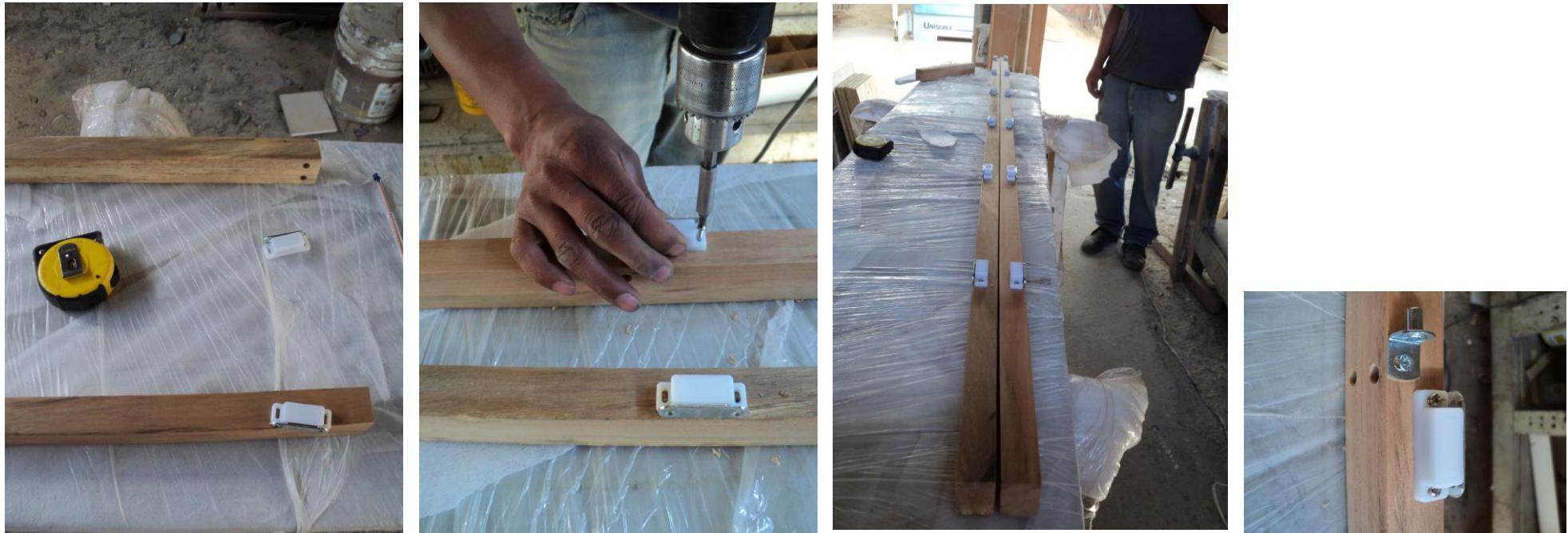
Fotografía 73, 74, 75 y 76: Construcción del prototipo.
