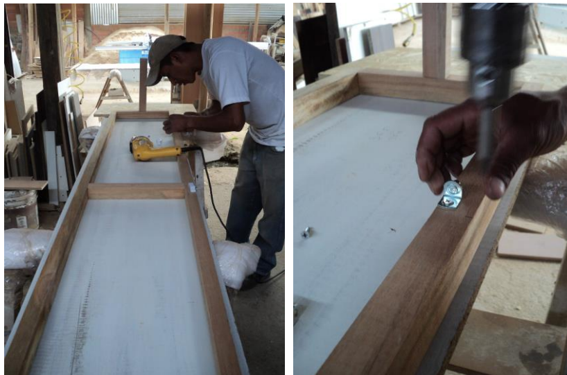
Fotografía 61 y 62: Construcción del prototipo.
