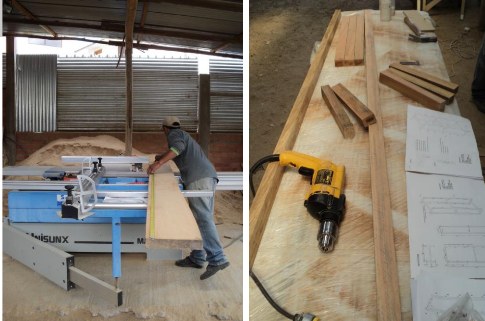
Fotografía 54 y 55: Construcción del prototipo.
