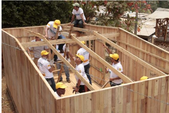
Fotografía 2: Voluntarios trabajando en construcción. Fuente: www.techo.org .
