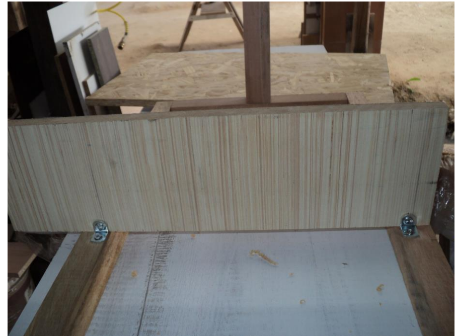
Fotografía 63: Construcción del prototipo.
