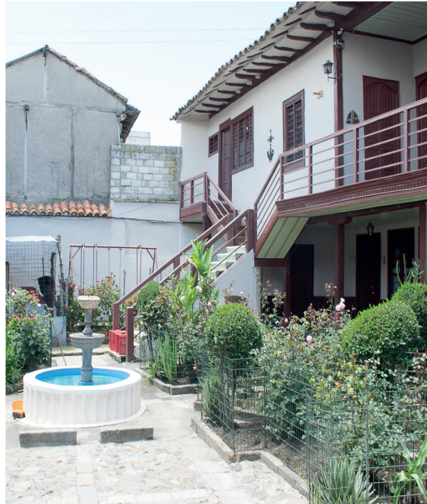
Fotografía 24. Cañar, Edificación vernácula en el centro histórico. Año: 2019 Fuente: Castro/Gutiérrez
