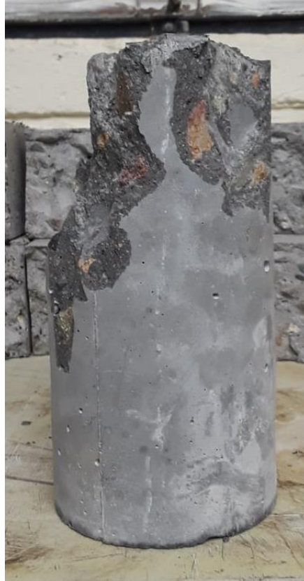
Ilustración 34. Tipo de falla 6.
