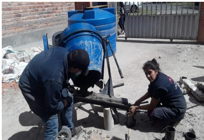
Ilustración 20. Paso 13a del procedimiento de mezclado.
