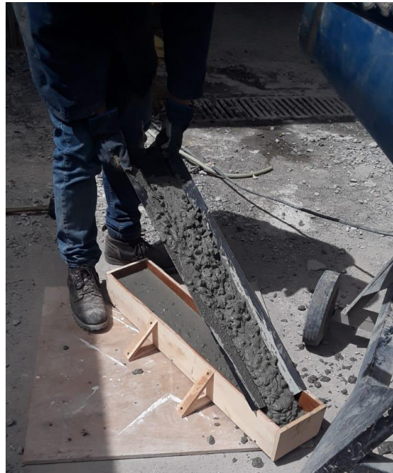
Ilustración 21. Paso 13b del procedimiento de mezclado
