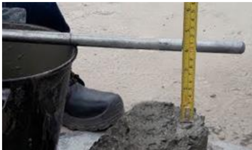
Ilustración 23. Revenimiento del hormigón.
