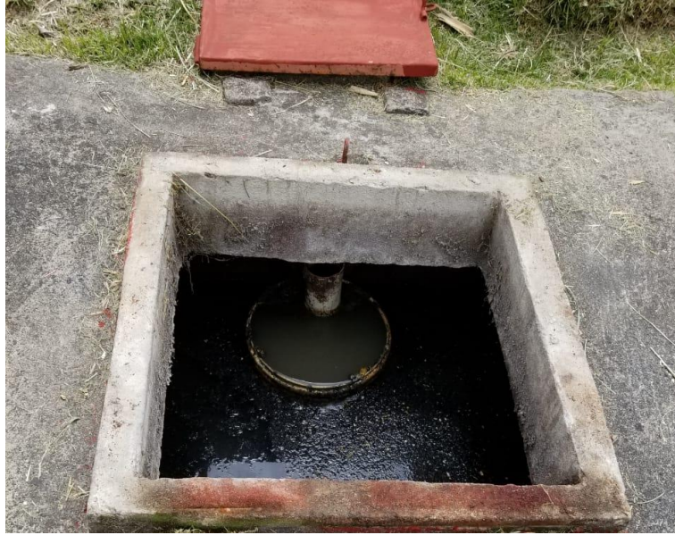
Ilustración 4. 2. Dispositivo de entrada al tanque séptico
