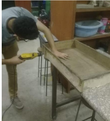
Figura 33. Preparación del sistema de encofrado
