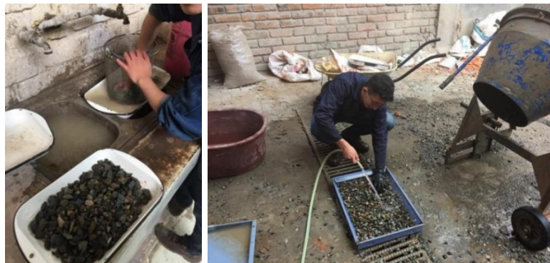
Figura 23. Lavado del árido, a usar en las mezclas de hormigón
