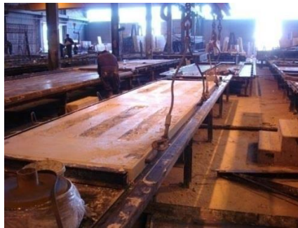
Figura 4. Paneles prefabricados. Recuperado de (Sánchez J. F., 2010)
