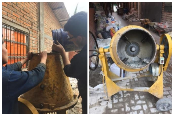
Figura 25. Proceso de mezclado del hormigón
