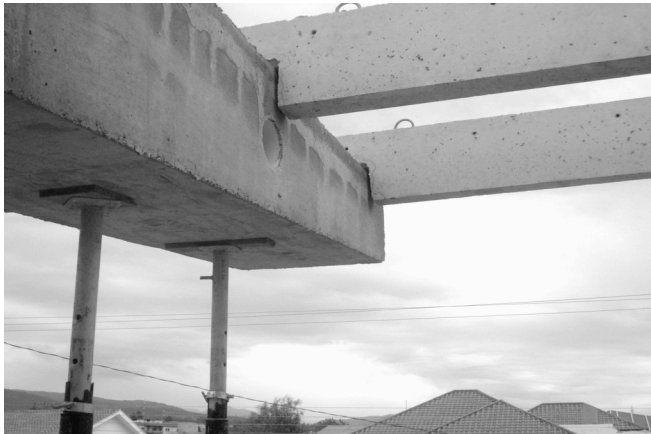
Viga cargadora en voladizo, sobre la que descansan finalmente las viguetas pretensadas.
