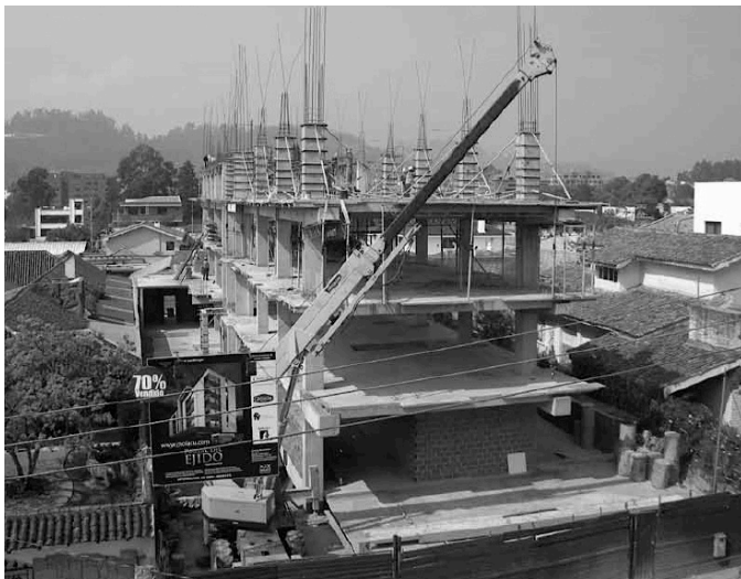
Detalles de grúas trabajando en el izado y montaje de elementos pretensados en la ciudad de Cuenca. Se observa la fuerte presencia de sistemas constructivos tradicionales que van incorporando poco a poco componentes prefabricados para mejorar los procesos y tiempos de montaje.
