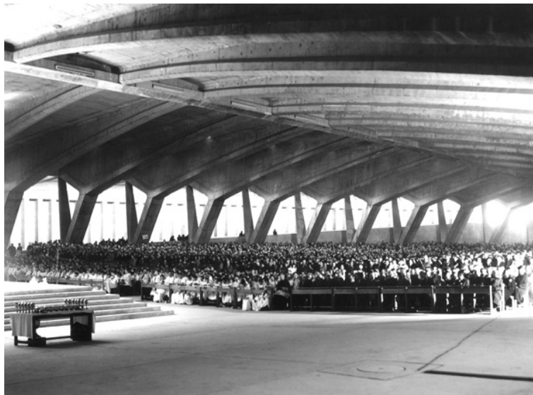
Detalles de la estructura interior de Basilica de Lourdes, un recinto enterrado de planta elíptica, proyecto de Freyssinet en donde el pretensado expresa su poderoso lenguaje en la arquitectura religiosa.
