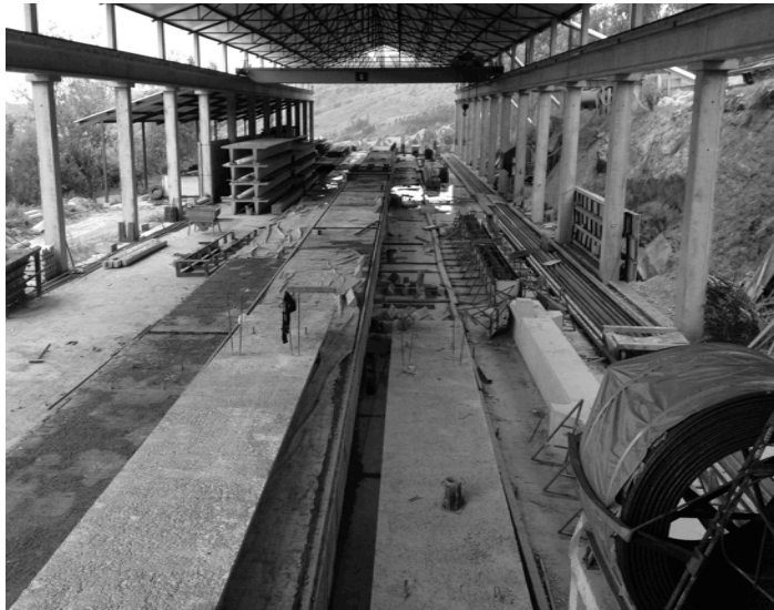
Planta de pretensados RFV. Cuenca-Ecuador. Vista general de nave principal
