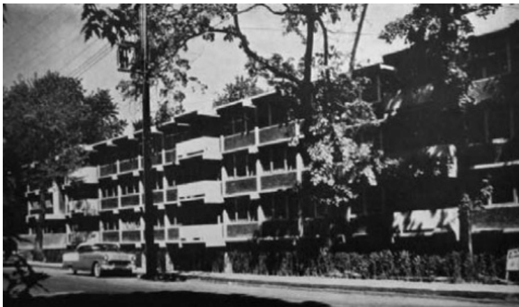
El boom de la prefabricación llegó a su auge en los EEUU de los años 60. Edificio de apartamentos con pilares y losas de hormigón pretensado 1963 Realizado por Taso Katselas y Brentnall Gensert.
