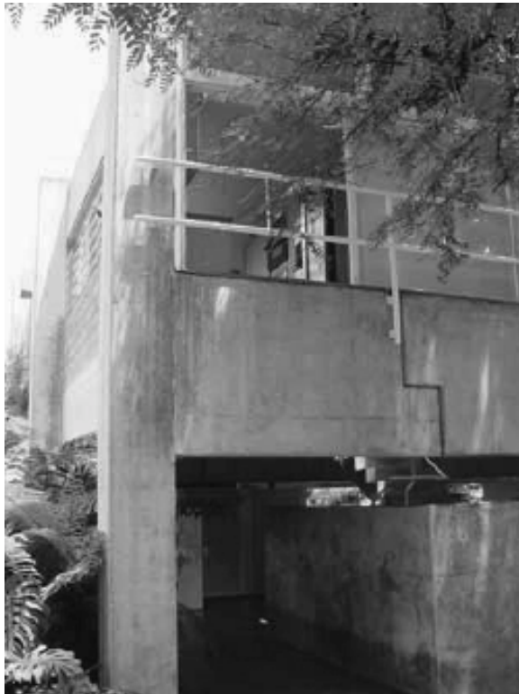
Casa Gerassi. Mendes da Rocha. La estética del pretensado define la casa sin ningún artificio ni material de "acabado"
