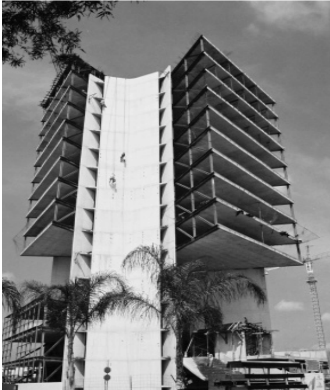
Torre Cube, Guadalajara. Losas postensadas de 22m en voladizo Fuente: www.luis.bozzo.com
