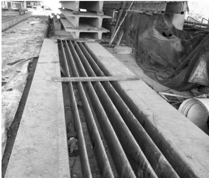
Planta de pretensados RFV. Cuenca-Ecuador. Detalle de encofrado tipo "cama"
