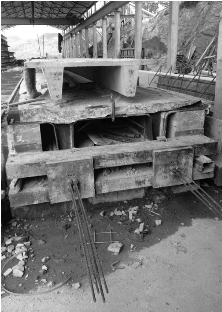
Planta de pretensados RFV. Cuenca-Ecuador.
