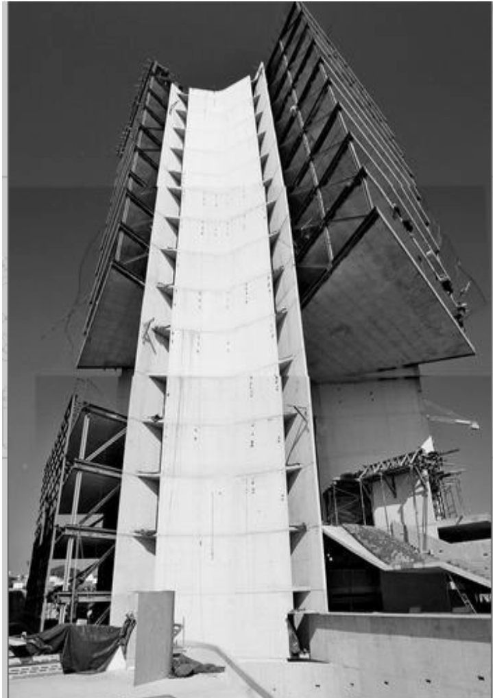
Carmen Pinós, Edificio Torre Cube. Guadalajara-México. Detalle del edificio en construcción, solucionado con pretensados de gran tamaño
