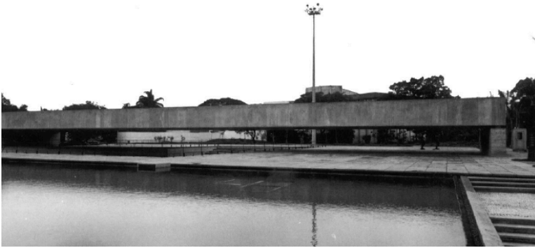
El MUBE (Museo Brasileño de Escultura) en Sao Paulo, impuso una nueva métrica de entender los espacios diáfanos gracias a la técnica del presforzado. (más de 60m de luz libre entre apoyos)
