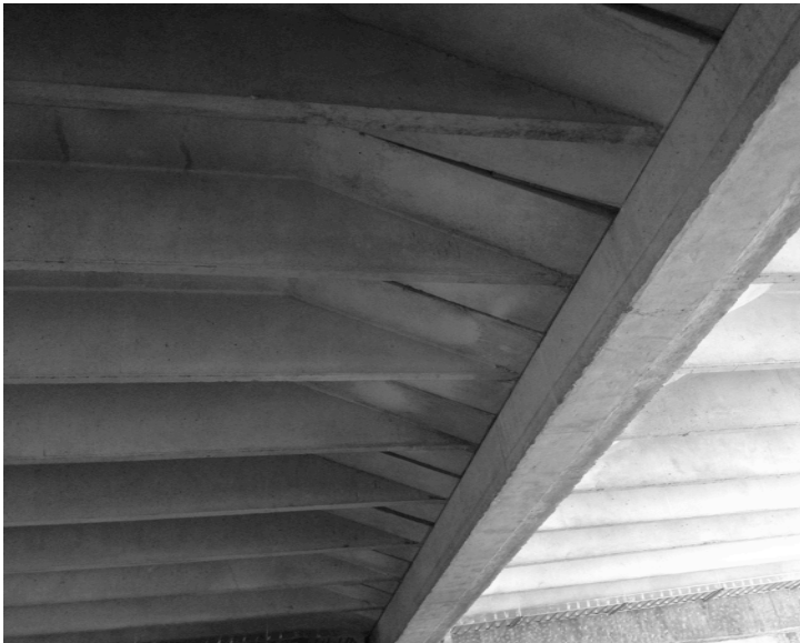
Detalle de elementos pretensados especiales, usados en el sótano de estacionamientos para el Parque de la Madre. Cuenca
