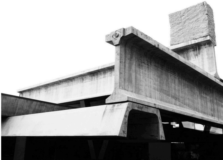
Casa Hemeroscopium. Ensemble Estudio. El equilibrio estructural entre los elementos pretensados y postensados se convierte el tipo arquitectónico final.
