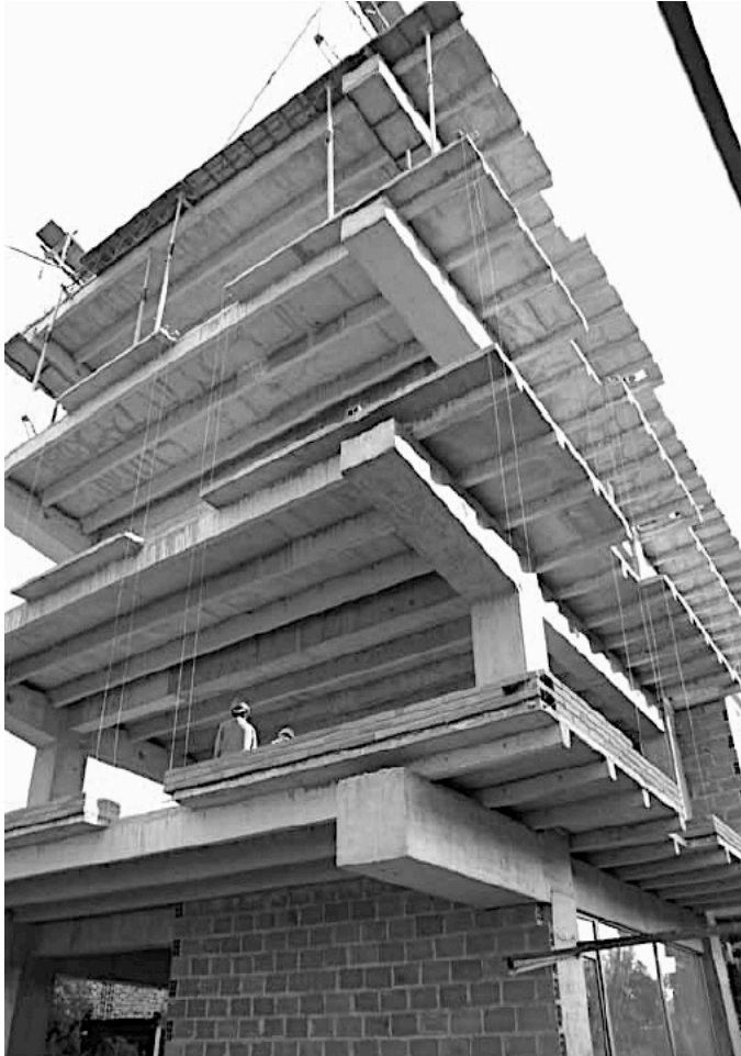
Edificio "Portal del Ejido". Cuenca. 2011. Estructura de 7 pisos más un subsuelo, que utilizó componentes prefabricados pretensados,
