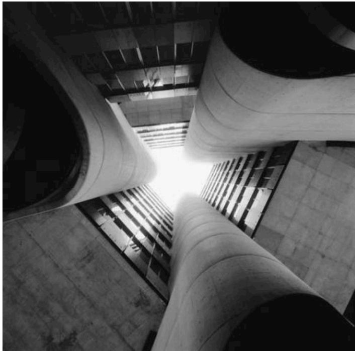
Torre Cube, Guadalajara. Obra de Carmen Pinós que revolucionó el planteamiento estructural de los sistemas postensados con núcleo central.
