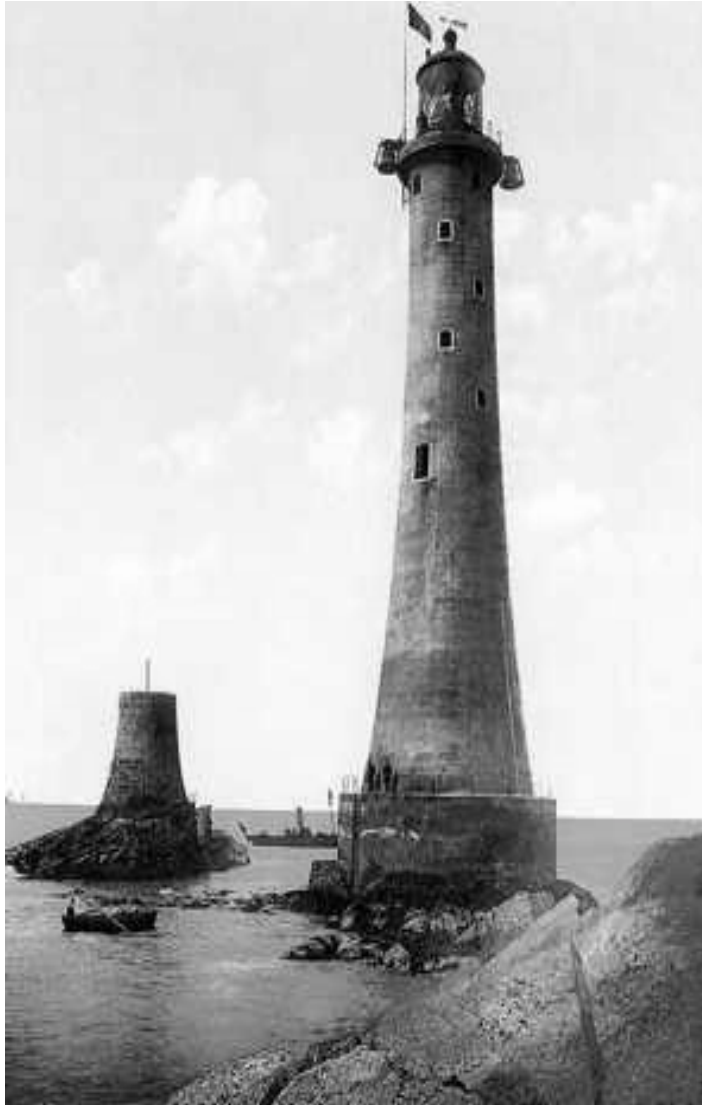
Imagen del faro de Cornwall, U.K. obra en donde el Ing. John Smeaton logró conseguir un material hidráulico al cual se le consideró como uno de los inicios técnicos del hormigón
