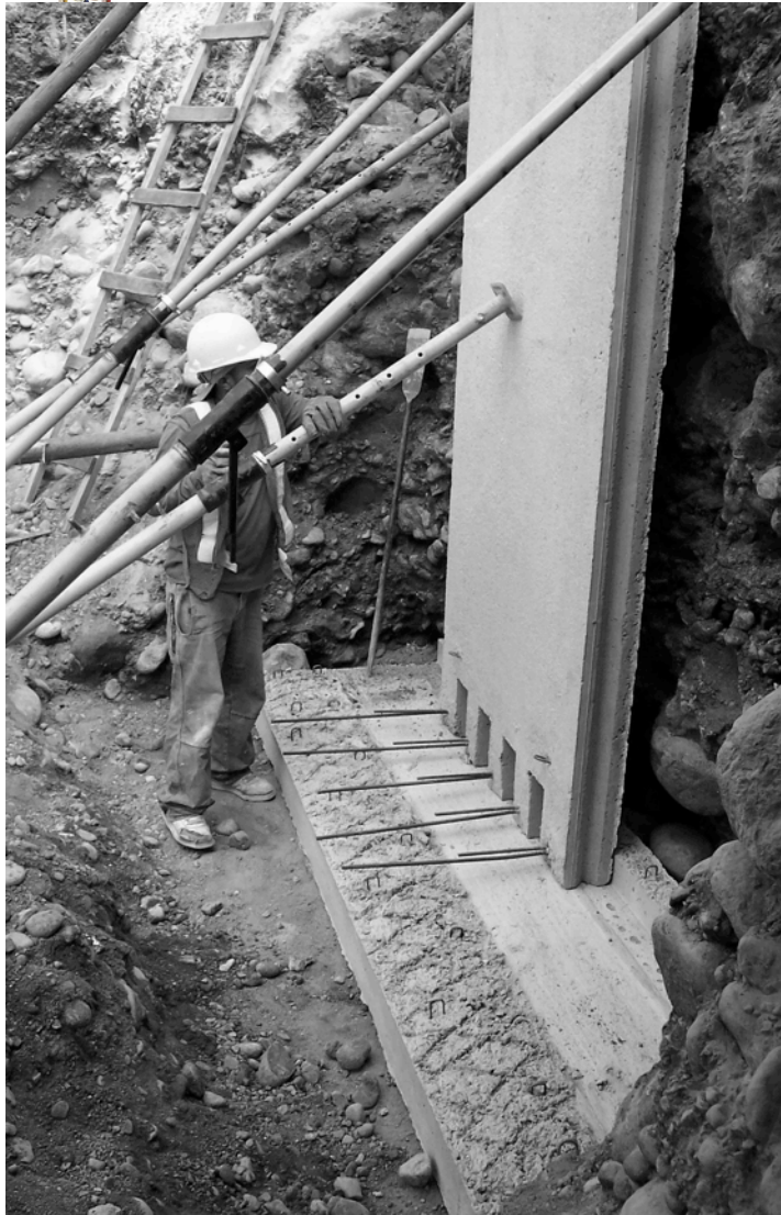
Detalle de montaje de un muro de contención macizo prefabricado que se ubica sobre una cimentación prefabricada. Los hierros a la vista y el dentado en la parte inferior del muro son diseñados para luego fundir sobre ellos hormigón en obra y conformar de ésta manera una unión monolítica
