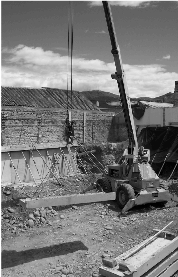
Grúa transportando y posicionando cimentaciones prefabricadas para la construcción de un sótano de parqueaderos en un edificio cerca del centro de Cuenca.
