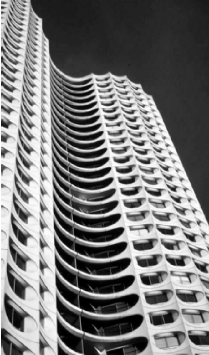
"Edificio emblemático en el momento de su ejecución [1971] al inicio de la utilización de las fachadas `singulares´ prefabricadas, mediante el empleo de vibrado por `choques´, moldes de fibra de vidrio y cemento blanco, construido en Rennes (Francia)".
