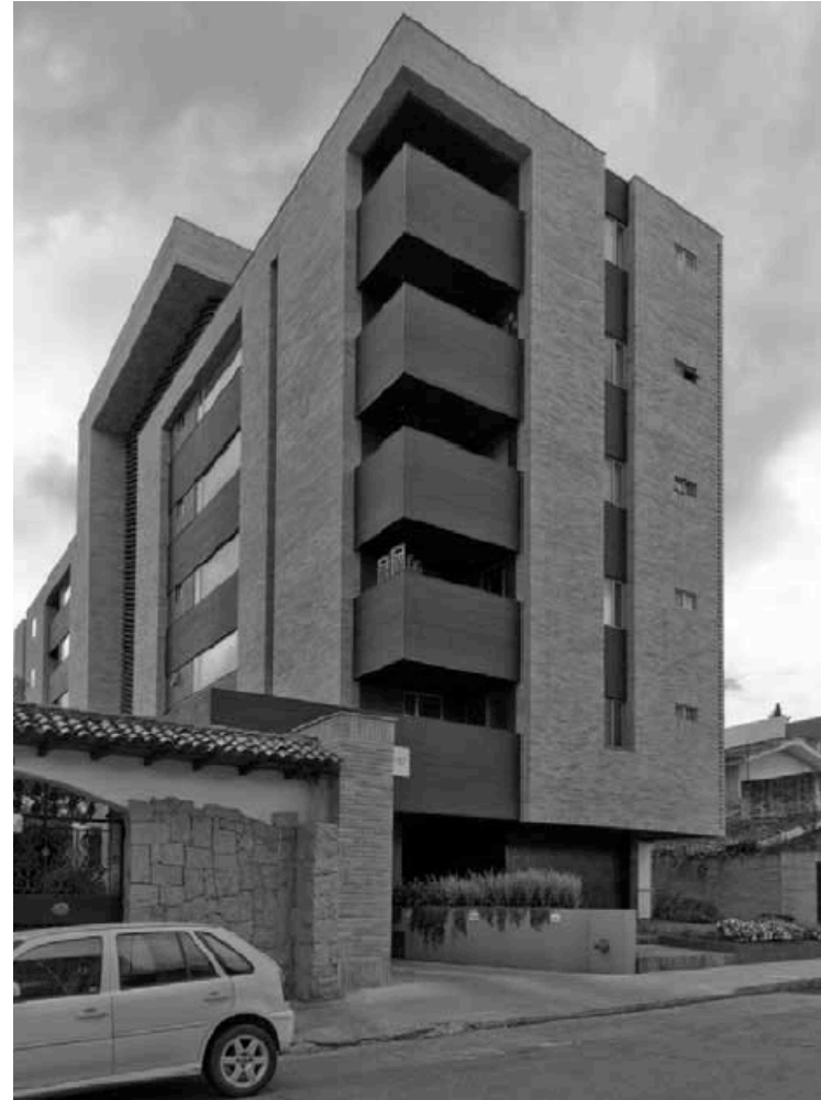
Edificio Portal del Ejido, Cuenca. Estructura de hormigón pretensado con envoltente de ladrillo Diseño: SurrealEstudio Arquitectura Construcción: RFV Carrasco Construcciones, año 2011.
