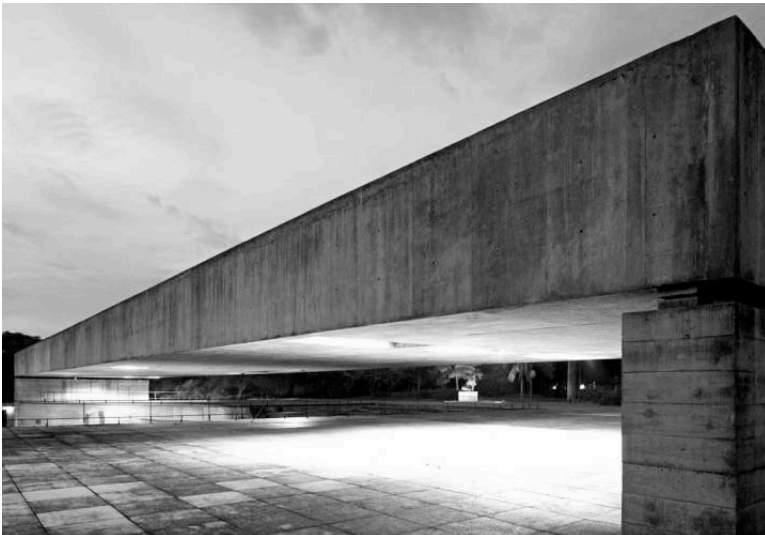
Detalle del MUBE (Mendes da Rocha). El gran dintel habitado de 100m de luz que libera toda la planta baja, un recurso recurrente de los grandes maestros brasileños. Obra fantástica que fue realizada gracias al entendimiento de la técnica.
