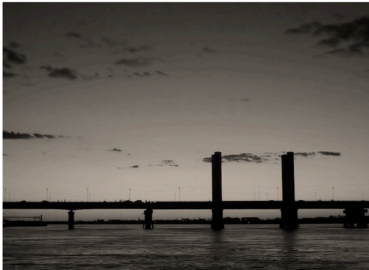
Arriba: Puente Juazeiro 1952 Construido por la empresa Freyssinet, que impuso un récord mundial en viga continua, con sus 561,45m en 13 tramos
