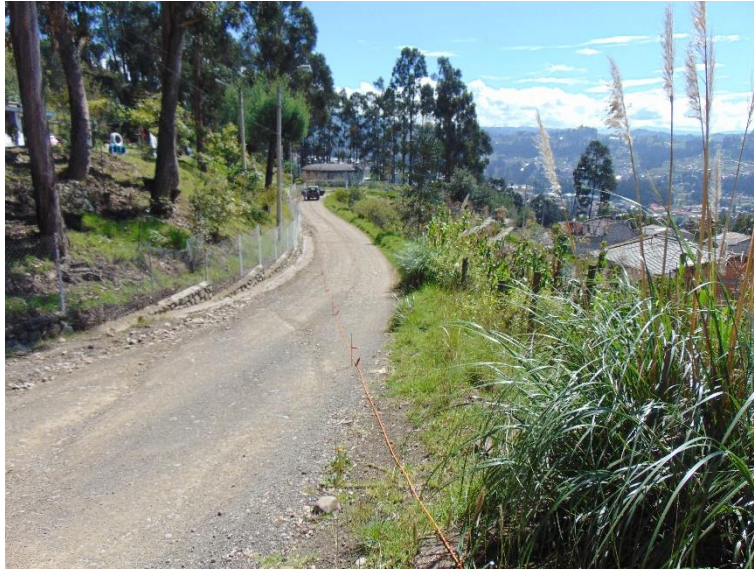
Foto N° 1 Levantamiento de la línea eléctrica LE-1
