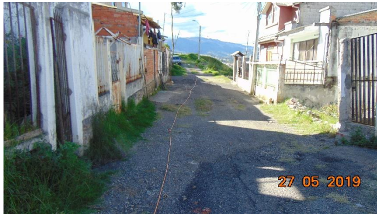
Foto N° 3 Levantamiento de la línea eléctrica LE-3
