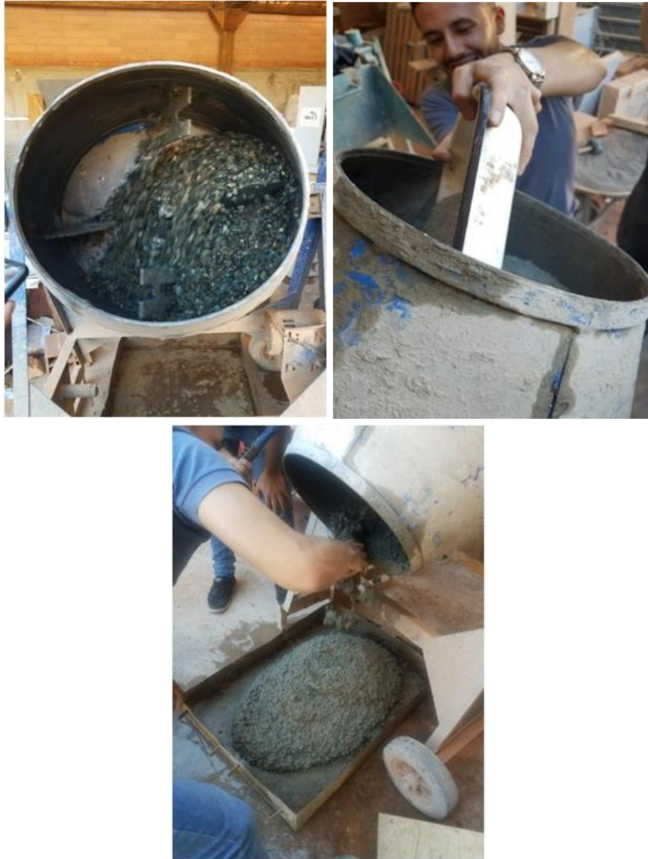
Figura 40. Mezclado del hormigón.
