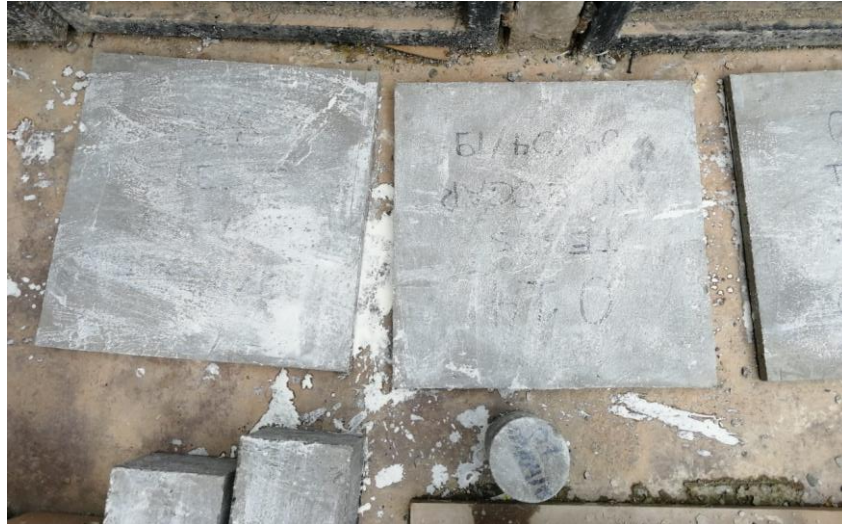
Figura 20: Curado de elementos mediante la aplicación de Antisol blanco.
