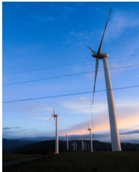
Figura 1. 23 Parque Eólico Villonaco ubicado en la ciudad de Loja [37]
