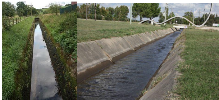
Figura 2. 15. Canales de riego de material suelto y de hormigón (Fuente: [12])
