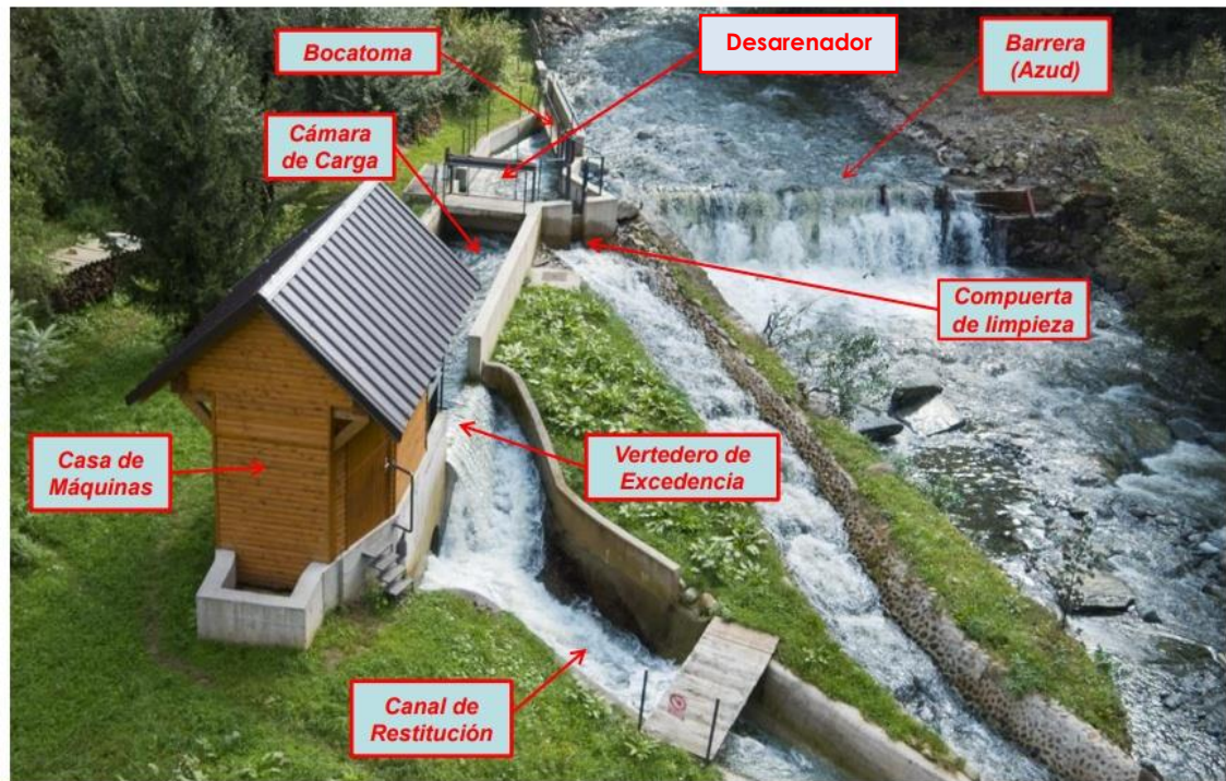
Figura 2. 5. Generación hidroeléctrica a pequeña escala. (Fuente: [6])
