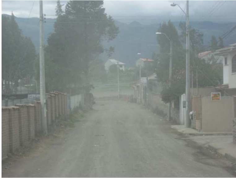
5: Vía secundaria ubicada en el sector del Tablón de Ricaurte
