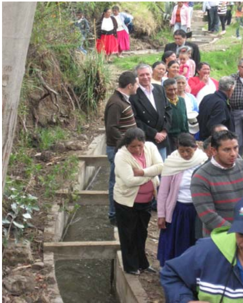
43: Instalación del canal de Riego (Obra de la Junta parroquial)
