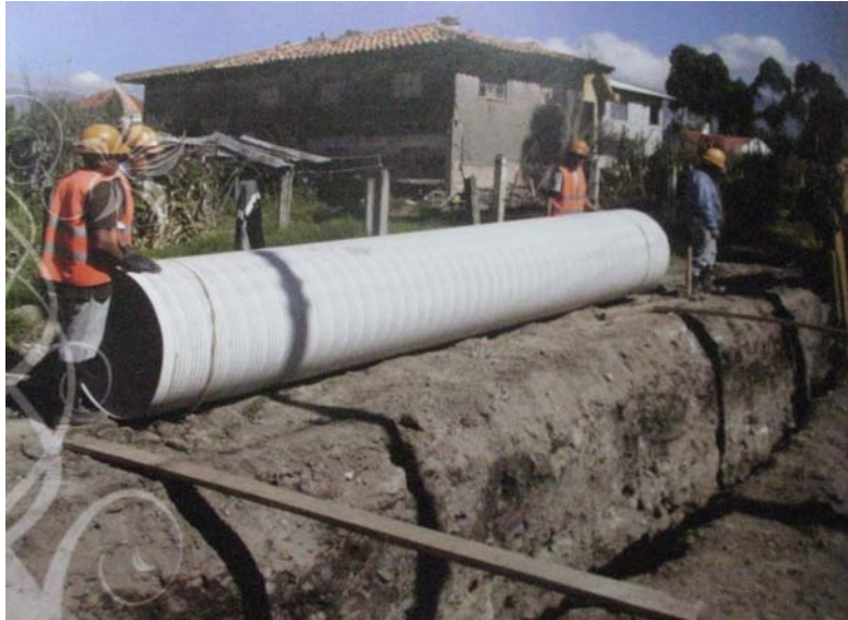
42: Instalación de Alcantarillado (Obra de la Junta Parroquial de Ricaurte)
