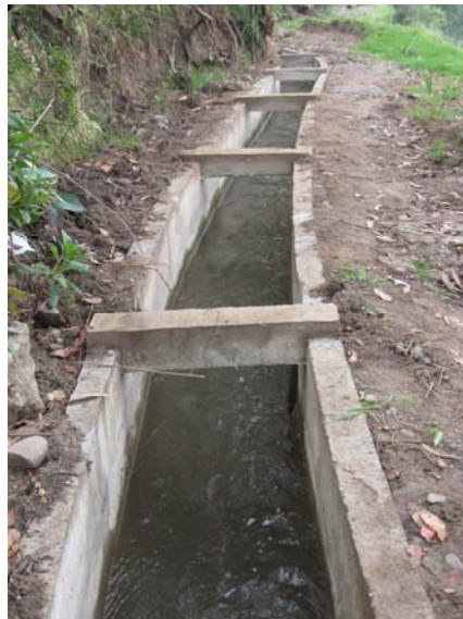
48: Canal de riego en el sector de San Miguel.
