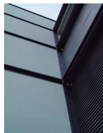
Gráfico 68: Dibujo de detalles en bocetos del aspecto exterior de la edificación y varias fotografías de la obra concluida.
