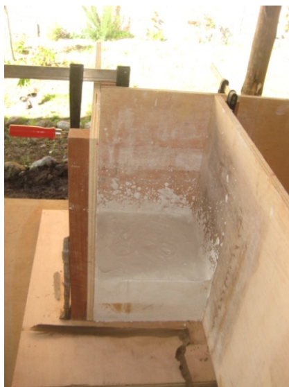
Ilustración 21: Aislado con jabón el piso y las paredes del encofrado.
