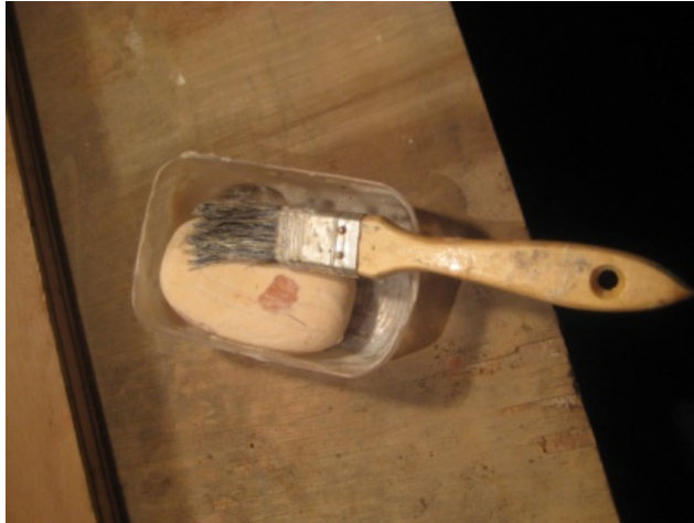
Ilustración 18: Es necesario aislar con jabón tanto el piso como las paredes del encofrado para evitar que la mezcla se adhiera.
