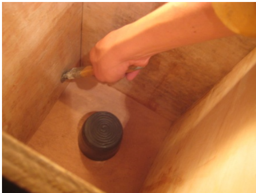
Ilustración 21: Aislado con jabón el piso y las paredes del encofrado.
