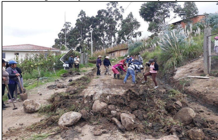
Figura 9 Limpieza de cunetas de la vía principal
