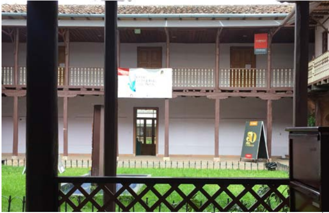
Fachada en el pasado
