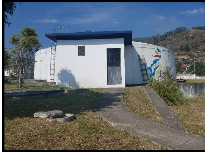
Ilustración 23. Tanque de Reserva ubicado en Parculoma con una capacidad de 500 m 3 .
