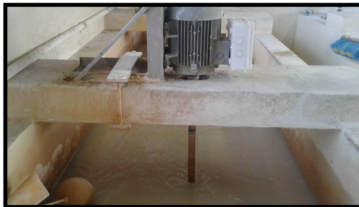
Ilustración 13. Motor de agitación de la mezcla de Cal/Carbonato de sodio En la casa de químicos PTAP Fuente: Autor
