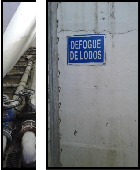
Ilustración 19. Tubería colectora de lodos del proceso de sedimentación. Fuente: Autor
