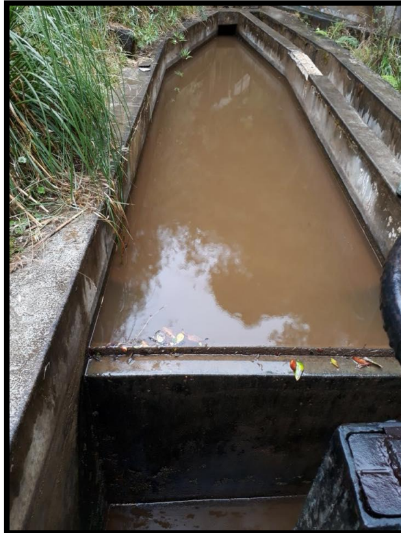
Ilustración 7. Conducción a través de canal abierto hacia las rejillas de la captación de Uchucay Fuente: EMAPAS-G-EP
