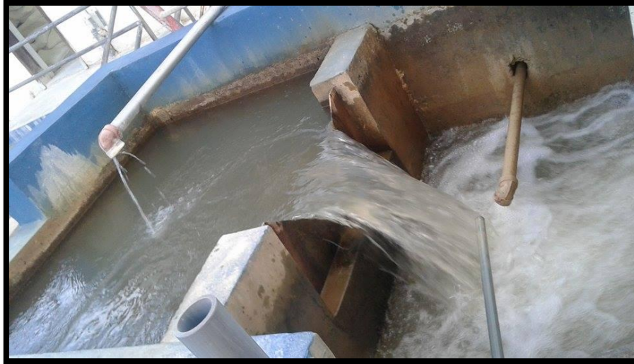
Ilustración 10. Vertedero hidráulico triangular
