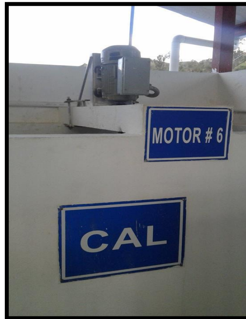
Ilustración 12. Tanque de mezcla de Cal/Carbonato Fuente: Autor
