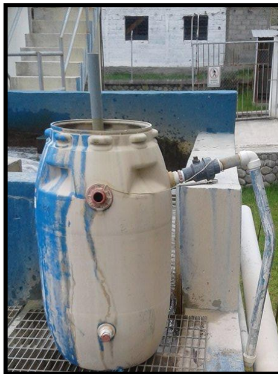
Ilustración 15. Tanque dosificador de vía húmeda de carga constante de Sulfato de Aluminio Fuente: Autor
