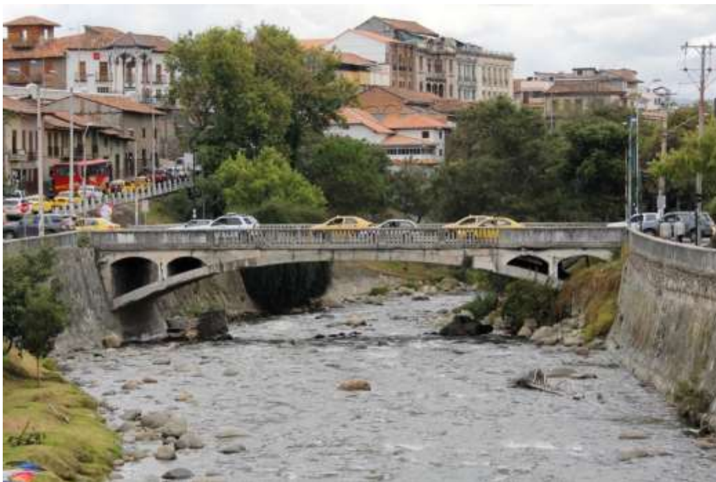
Figura 15. ISRAEL MUÑOZ Estado actual del Puente de "El Vado". 2016
