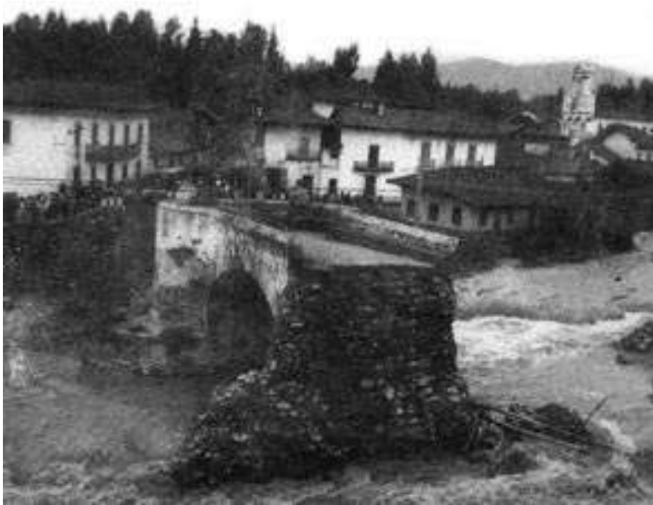
Figura 12. Puente de El Vado destruido después de la crecida de 1950.
