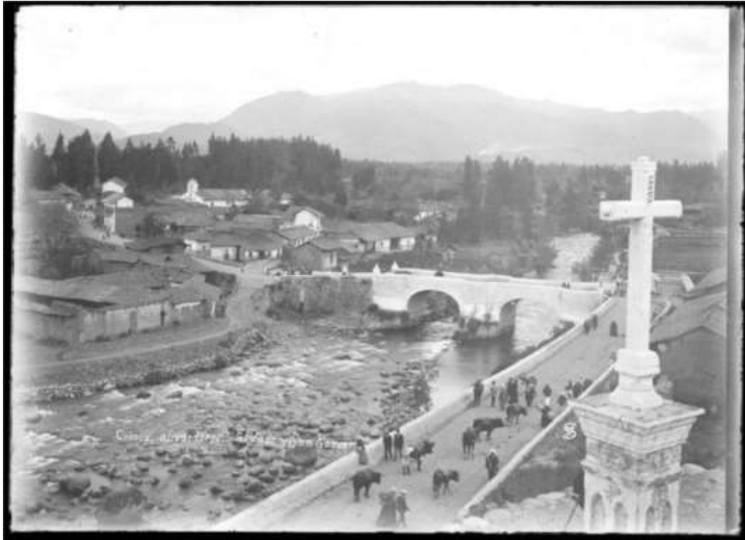
Figura 11. J. M. SERRANO Cruz del Vado y primer puente, 1920-1930. Recuperado de: fotografianacional.gob.ec
