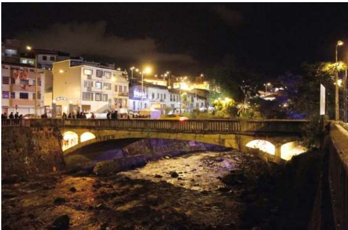
ISRAEL MUÑOZ Parábola del progreso. Puente de El Vado, Cuenca-Ecuador. 2017
