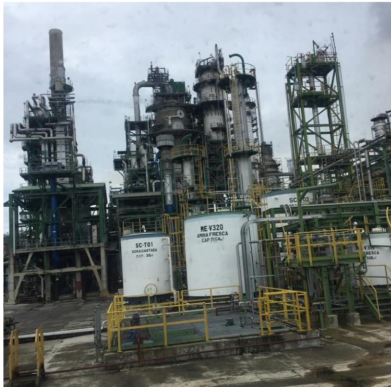
Figura 56. Fotografía de unidades de lavado cáustico en la REE.
