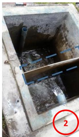
Ilustración 10. Segundo tanque rompe presión (placa metálica sirve para evitar el golpe brusco del agua y salpicadura del mismo).
