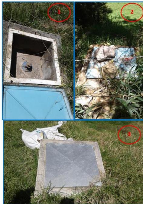
**Ilustración 32. Válvulas para la limpieza de la tubería (purga), con tapa.**
