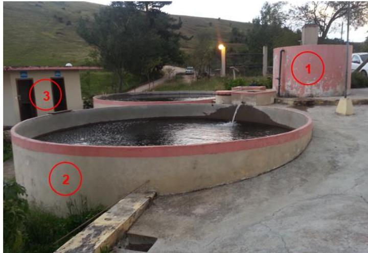
Ilustración 20. 1.- Tanque prefiltro; 2.- Filtro lento y 3.- Área de desinfección.
