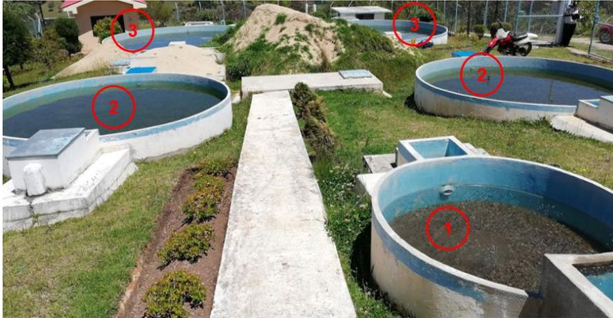
Ilustración 36. 1.- Tanque prefiltro; 2.- Prefiltros mayor y 3.- Filtros lento al fondo.
