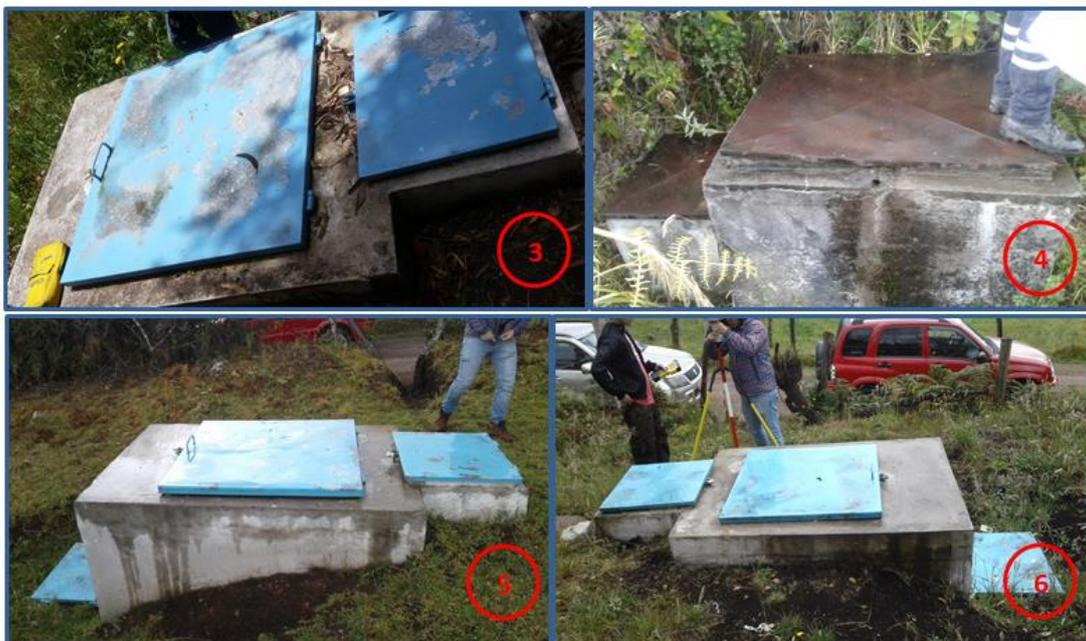
**Ilustración 12.** Tanques rompe presión.
