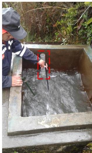
Ilustración 14. Elemento expulsador de aire adaptado en el 4to tanque rompe presión.
