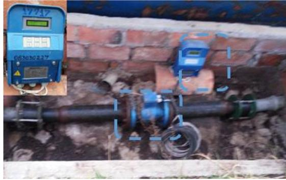
**Ilustración 17. Caudalímetro electromagnético.**
