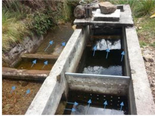
Ilustración 3. Sentido de flujo en la captación y derivación.
