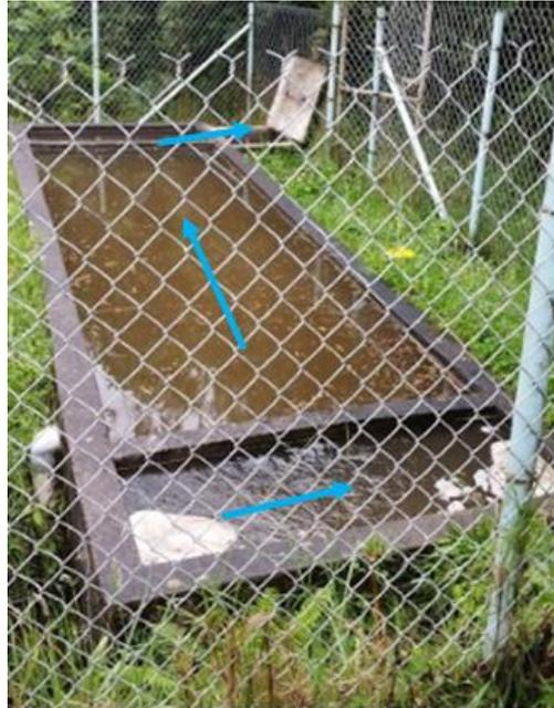
Ilustración 51. Desarenador ubicado previo a la conducción.
