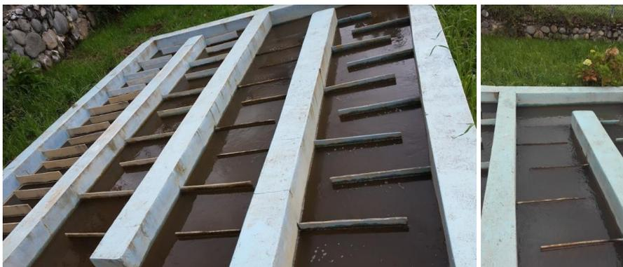
Ilustración 95. Floculadores muy deteriorados.
