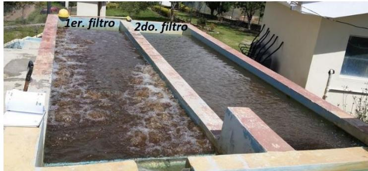
Ilustración 83. Filtros dinámicos: a). Lavado del primer filtro y b). Segundo filtro operado normalmente.
