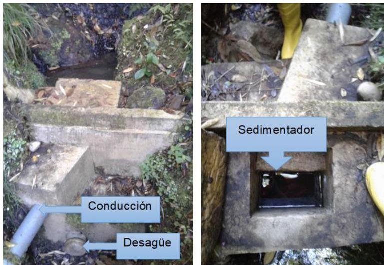
Ilustración 29. Modelo de segunda captación de agua cruda.
