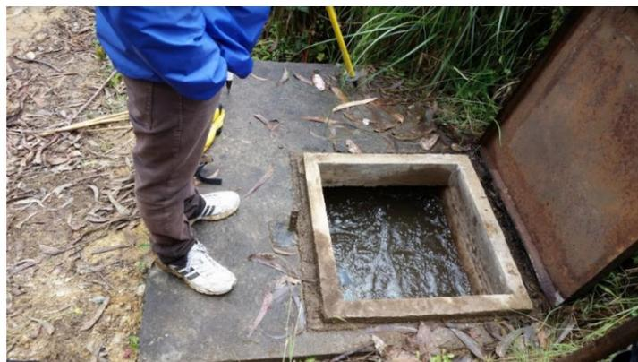
**Ilustración 53. Único tanque rompe presión en la conducción.**
