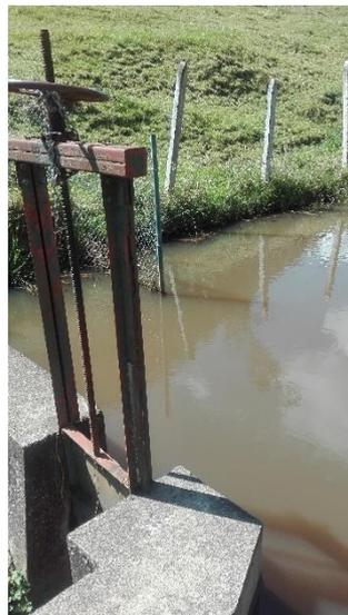
Ilustración 76. Compuerta de ingreso del agua presenta corrosión
