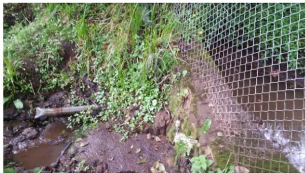
**Ilustración 89. Tubería de desfogue de la captación.**
