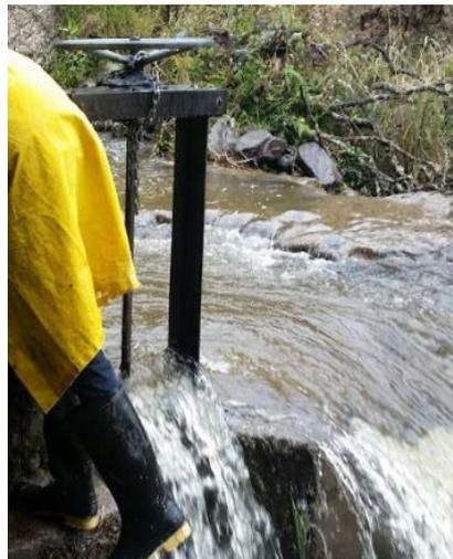
**Ilustración 50. Válvula de compuerta de la captación.**
