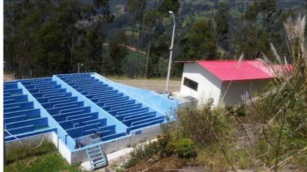
**Ilustración 71. Instalaciones de la planta de tratamiento: floculadores, casa de medición de caudal, almacén y medición de sulfato y polímero.**
