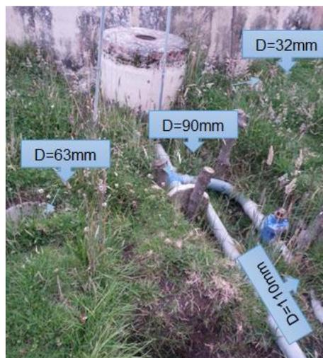
Ilustración 28. Diámetro de tuberías de salida hacia la red de distribución.
