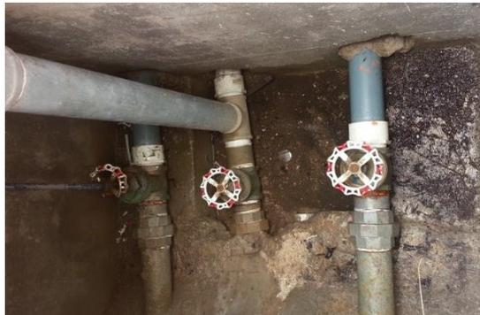
Ilustración 56. Válvulas de desfogue para el lavado de los filtros.
