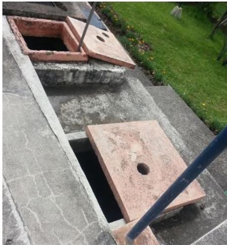
Ilustración 58. Tapas de acceso a los filtros y válvulas.
