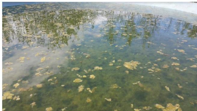
**Ilustración 40. Presencia de algas en la superficie del tanque filtro lento.**
