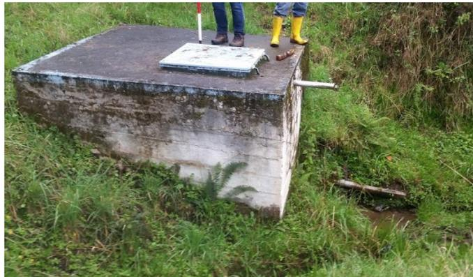
Ilustración 87. Tanque recolector.
