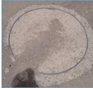
Ilustración 67. Tapa de estructura contenedora de válvula de aire.
