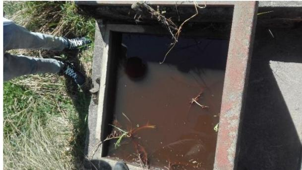
**Ilustración 78. Tanque recolector con presencia de vegetación y sedimentos.**
