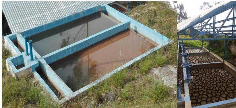
Ilustración 70. Estructura para el tratamiento y secado de lodos.
