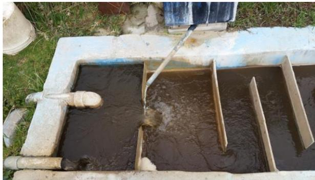
Ilustración 93. Adición de sulfato en la unidad de floculación.
