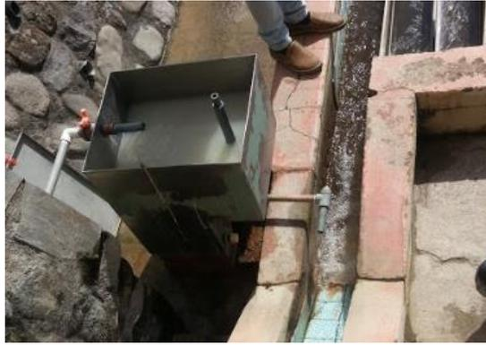
Ilustración 55. Conducción de agua hacia los floculadores.
