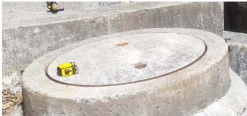
Ilustración 63. Tapa de tanque de revisión.
