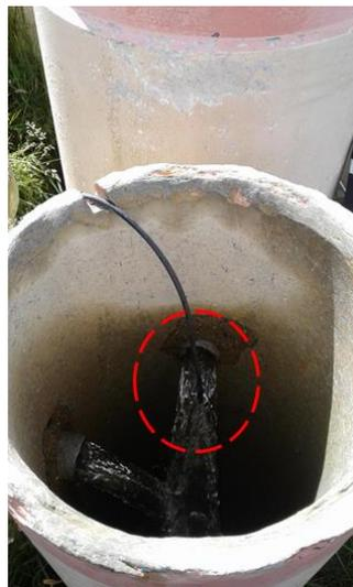
**Ilustración 23. Tanque de cloración del agua (mezclado de agua y cloro líquido).**
