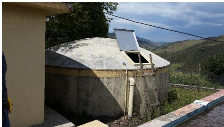
Ilustración 84. Tanque utilizado para el lavado de los filtros dinámicos.
