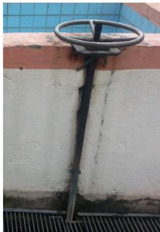
Ilustración 59. Válvula de compuerta de paso de reactivos hacia los floculadores.
