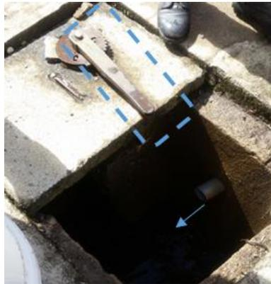
**Ilustración 18. Válvula de evacuación.**
