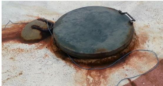
**Ilustración 25. Óxido sobre la tapa de la cúpula del tanque de almacén.**
