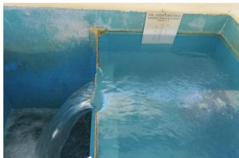
**Ilustración 35. Vertedero de pared delgada para el ingreso de agua cruda a la PTAP.**
