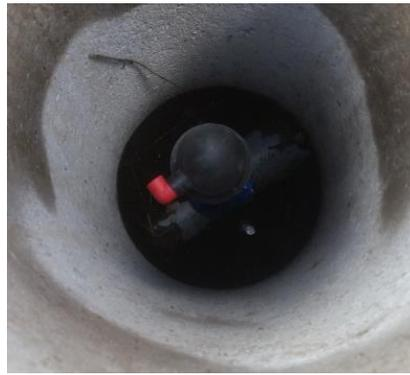
Ilustración 13. Válvula de aire.
