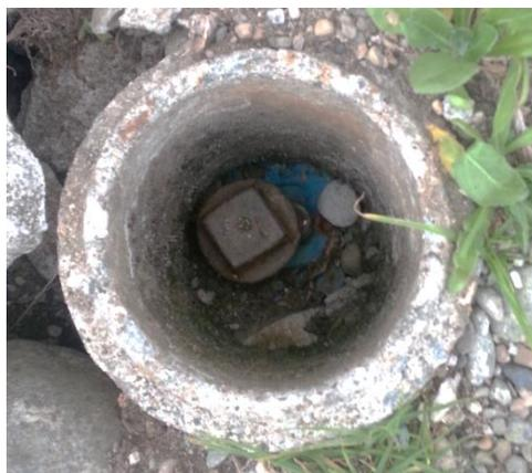
**Ilustración 19. Válvula de salida para tanque prefiltro.**
