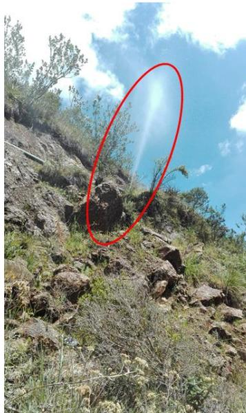
**Ilustración 81. Fuga de agua por agujero en la tubería que actúa como “aireador”.**
