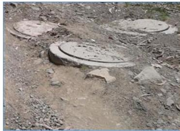
Ilustración 68. Tapas de estructuras deterioradas.
