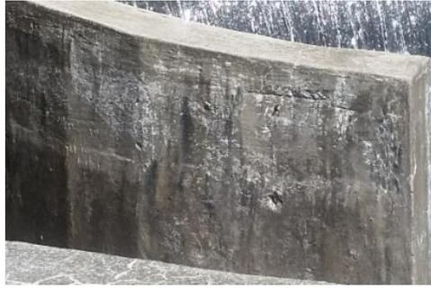
**Ilustración 64. Paredes levemente erosionadas del canal de excesos.**
