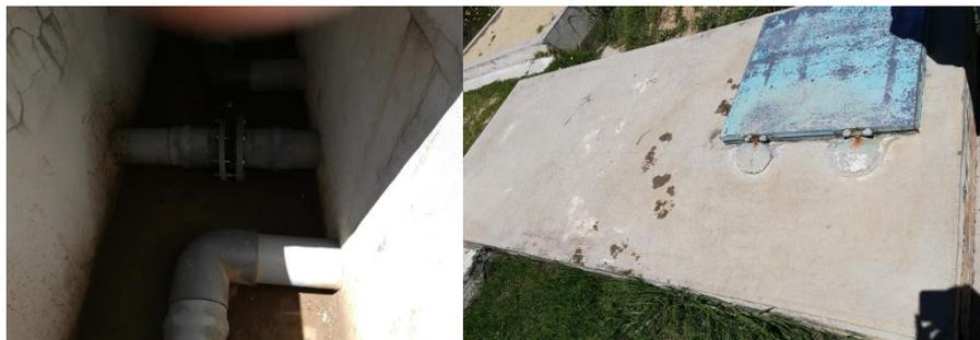
**Ilustración 41: Válvulas de salida de filtros lentos.**
