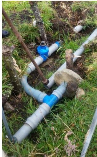
Ilustración 27. Tuberías de salida para dotación.
