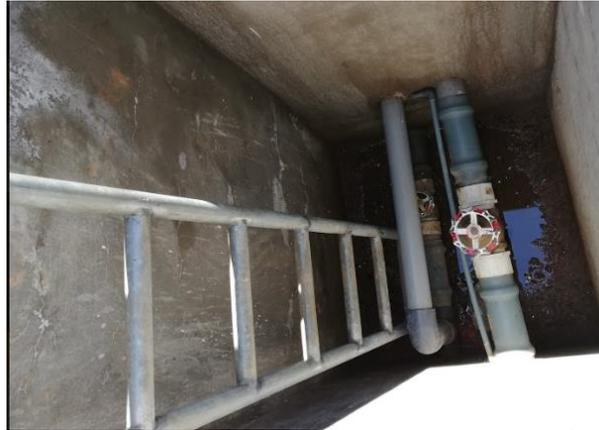
Ilustración 47. Válvulas de salida del tanque de almacenamiento.
