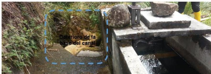
**Ilustración 7. Fondo del canal de la captación y sus daños.**
