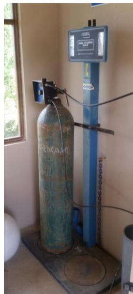
Ilustración 21. Cilindro de cloro gas.
