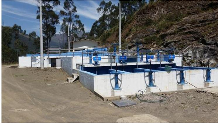
Ilustración 69. Instalaciones de la planta de tratamiento: al frente las unidades de filtración.
