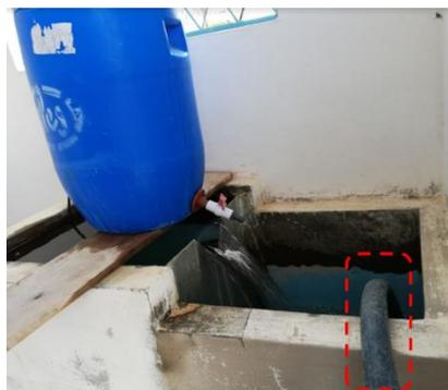
Ilustración 43. Tanque para la mezcla de hipoclorito.
