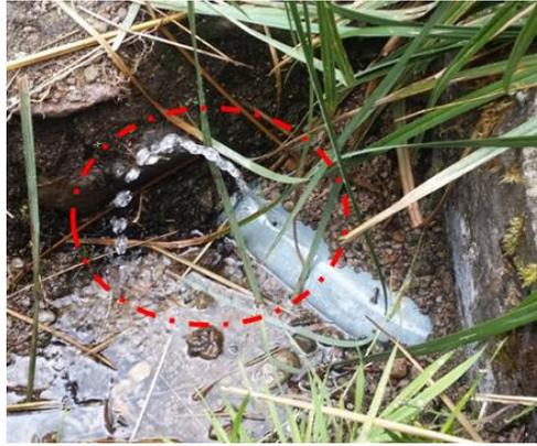
Ilustración 8. Perforación a la tubería sirve para "expulsar aire".
