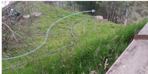
**Ilustración 26. Línea de drenaje para rebose de tanques.**
