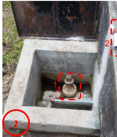
**Ilustración 11.** Segundo tanque rompe presión (1.- Válvula de paso y 2.- Manguera para extracción de aire).
