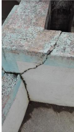
**Ilustración 96. Grietas del hormigón.**
