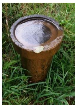
Ilustración 90. Aireadora que presenta fuga y desbordamiento del agua.
