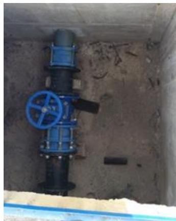
**Ilustración 73. Válvulas de paso para lavado de filtros y sedimentadores.**
