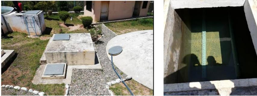
Ilustración 44. Tanque para la mezcla de cloro gas.
