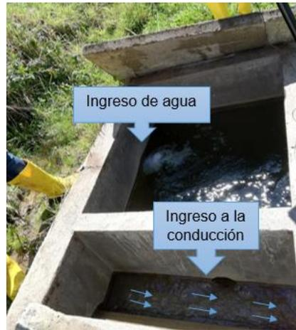
Ilustración 31. Tanque recolector de para las captaciones y su sentido de flujo.
