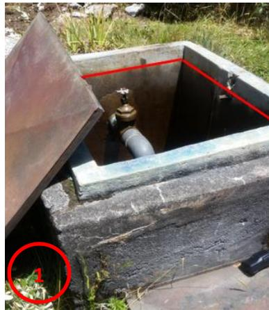
Ilustración 9. Primer tanque rompe presión.
