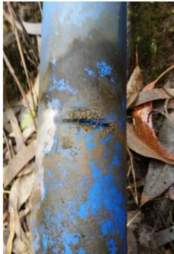
**Ilustración 52. Corte en la tubería de conducción.**
