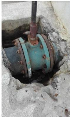
**Ilustración 97. Conexión de tubería de acero presenta corrosión.**
