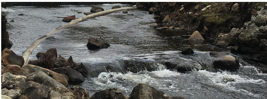
Ilustración 22 Tubería de la conducción.
