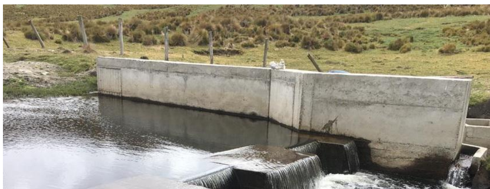
Ilustración 6 Muro de encauzamiento.
