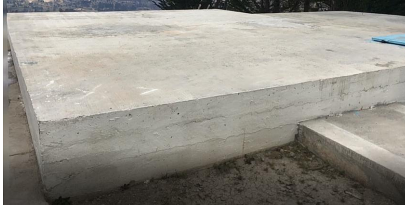
Ilustración 71 Tanque de reserva 1
