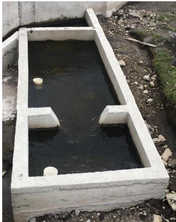
Ilustración 9. Cámara de captación.
