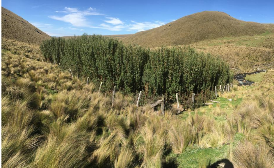
Ilustración 18. Cerramiento de los filtros de pretratamiento.
