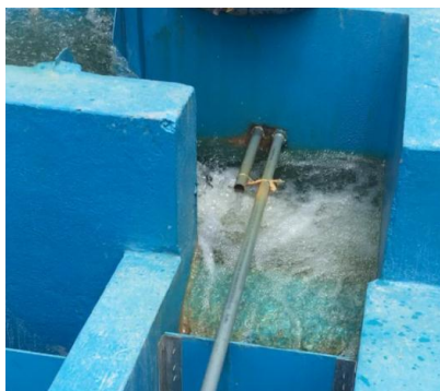
Ilustración 33 Punto de aplicación del coagulante.
