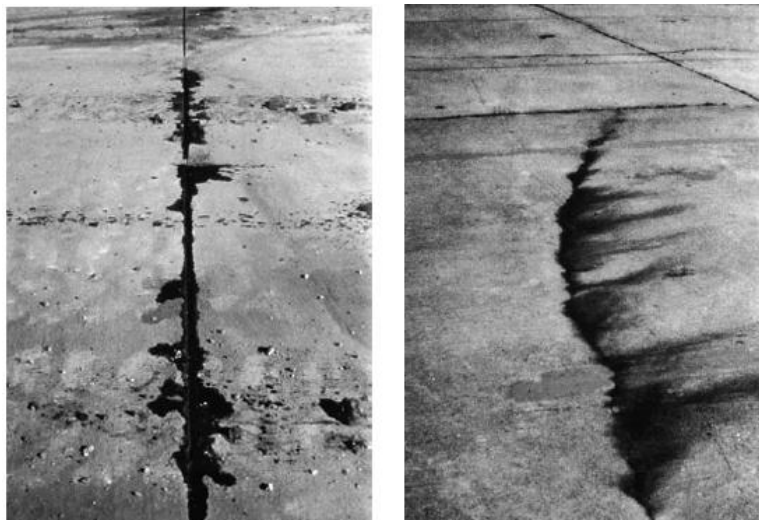
Fig. 14. Bombeo de losa. ASTM, 2011.
