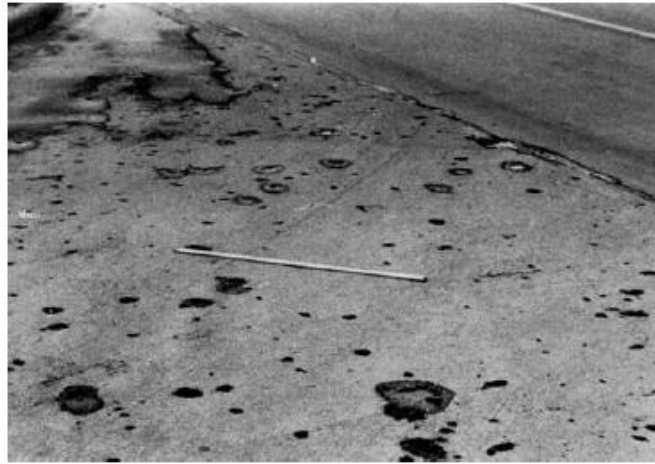
Fig. 13. Huecos en losa. ASTM, 2011.
