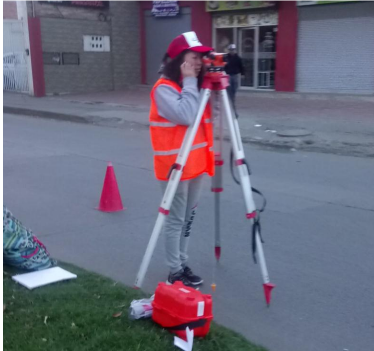
Fig. 58. Medición de los puntos con el nivel topográfico.
