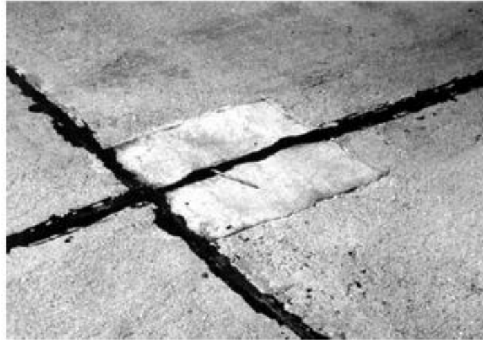
Fig. 11. Parcheo pequeño de severidad baja. ASTM, 2011.
