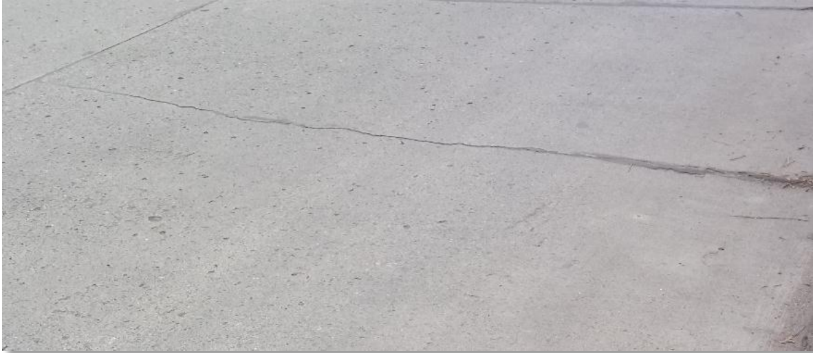
Fig. 43. Deterioro: agrietamiento lineal (transversal); severidad: media. Losa 8 de la sección 17 del carril #1 en la Avenida Loja.
