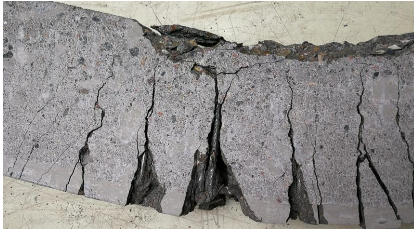
Ilustración 18 Falla a flexión en las vigas con f'c de 1000 Kg/cm 2 .
