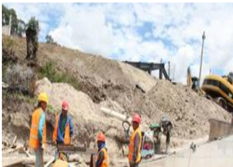
Figura 39: Construcción del Megaparque de la Luz con coordenadas geográficas (-2.878952,-78.992872).
