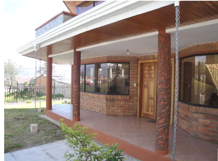
(73) Columnas Decoradas Relieve en Cemento Diámetro de 0,3m. x 2,3m, 2009
