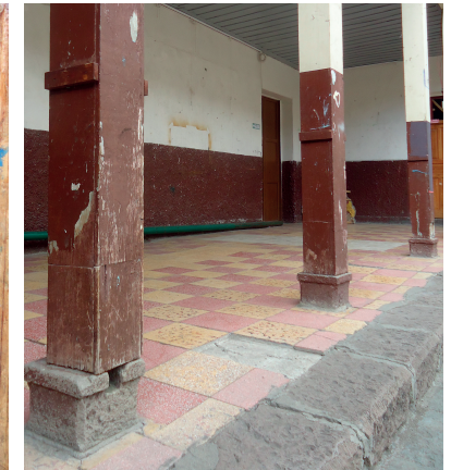
Fig 204: Desgaste de maderas
