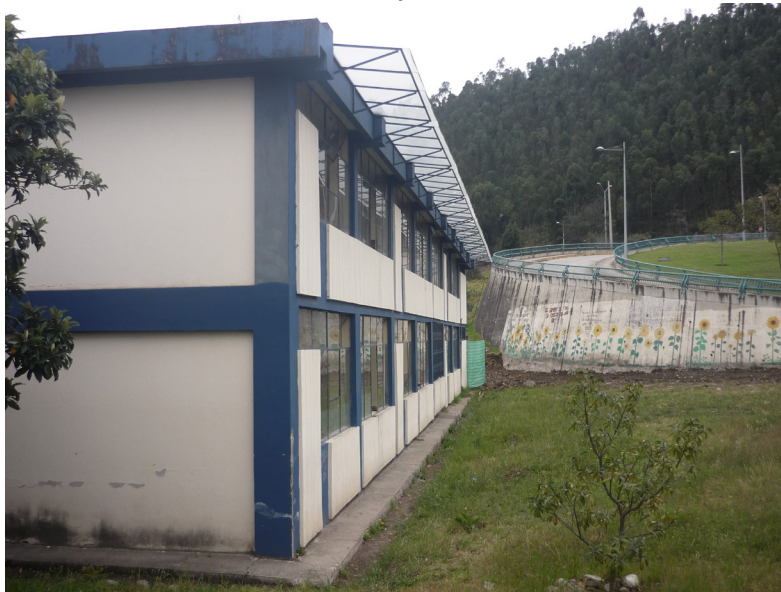
Imagen II.8 Fotografía de uno de los pasillos del colegio Manuela Garaicoa de Calderón
